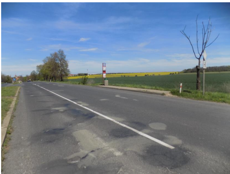
Obrázek 13 - Autobusová zastávka Zdiby, U Celnice – směr z Prahy
