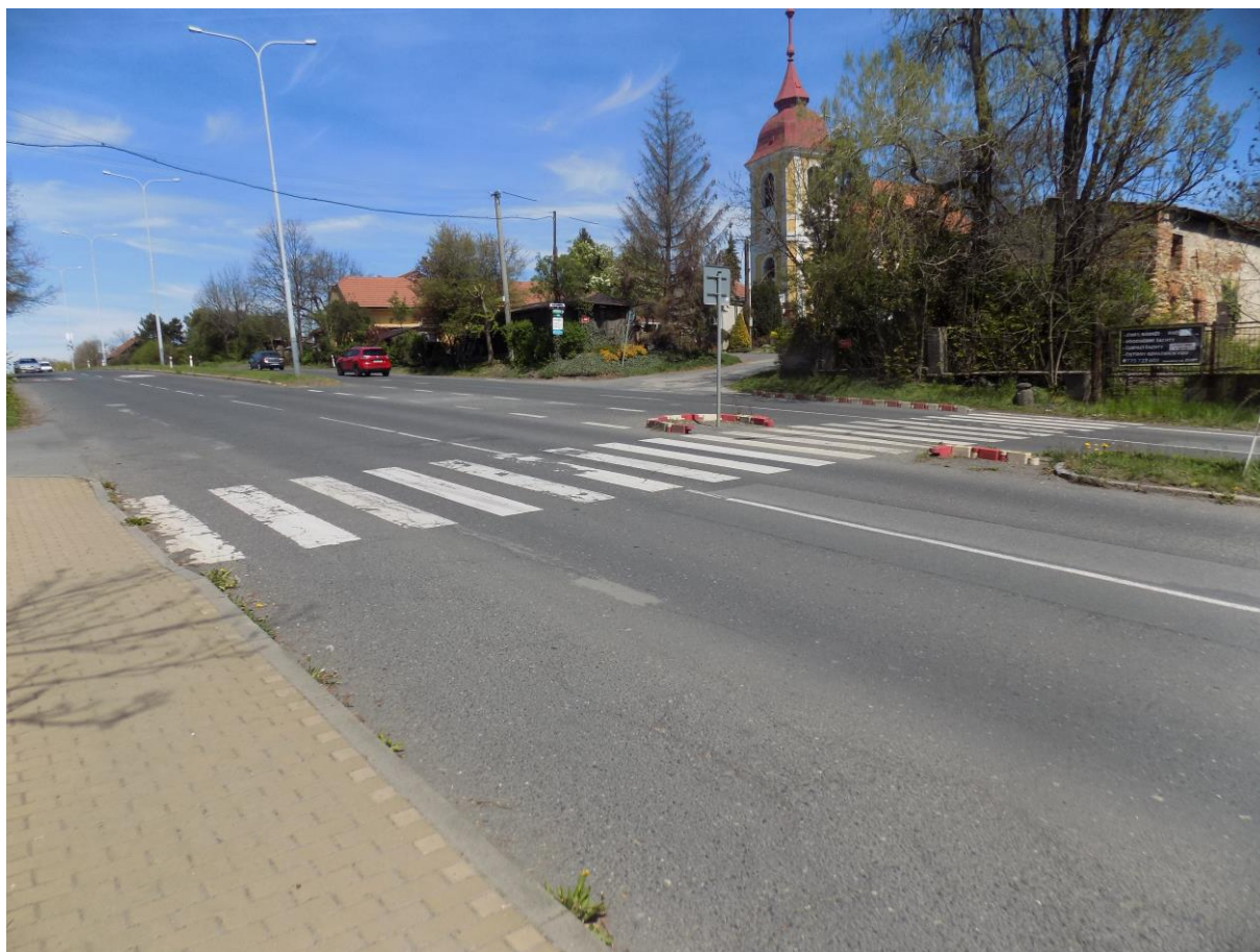
Obrázek 17 - Přechod pro chodce přes ulici Pražská
