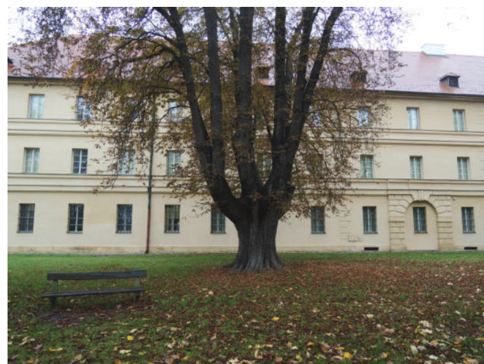
Fotografie 1 - pohled na část jižního průčelí budovy
