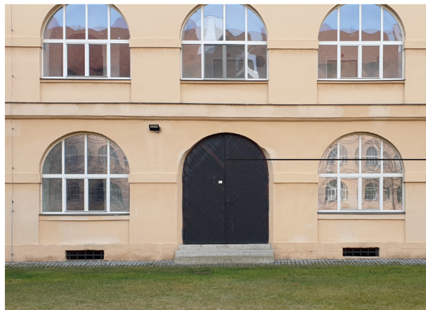
Fotografie 2 - pohled ze dvora na stávající dveře „D0“ snímek poskytl pan Ing. Tomáš Sklenář, DiS
