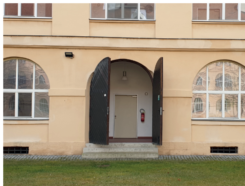
Fotografie 1 - pohled ze dvora na stávající dveře „D0“ snímek poskytl pan Ing. Tomáš Sklenář, DiS
