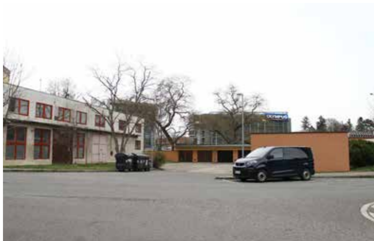
Pohled na parkovací zákoutí a vjezd k výměňkové stanici teplovodní soustavy.
