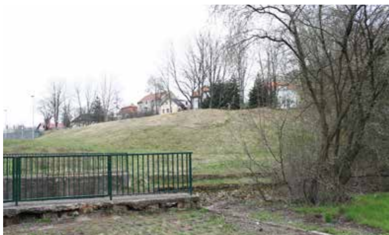
Pohled na lem betonového koryta potoka situovaného mimo horizont očí.
