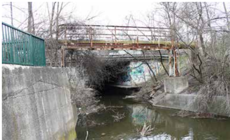
Pohled na betonové koryto procházející pod Evropskou ulicí.
