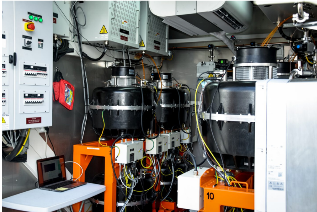
Obrázek 8 - Systém úložiště setrvačnickové baterie [58]
