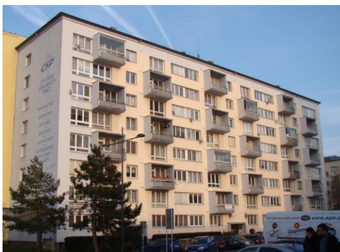
Obr. 2.5 Čelní pohled na panelový dům soustavy T06B-OS [3]
