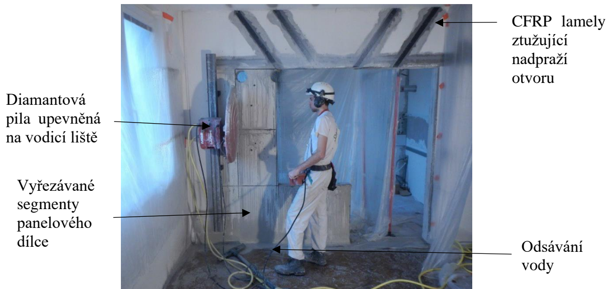
Obr. 4.5 Rozšíření stávajícího dveřního otvoru [10]
