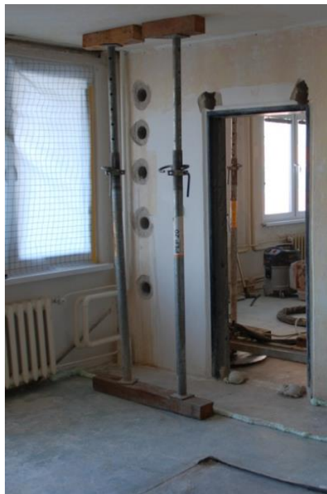
Obr. 4.2 Podepření stropní konstrukce [10]
