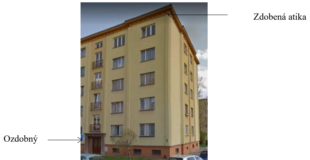
Obr. 2.3 Prvky fasády soustavy G40 [2]
