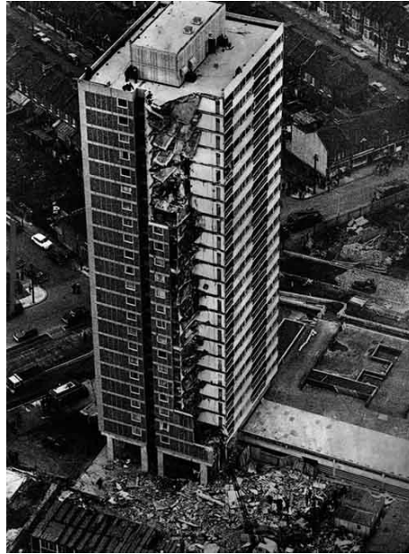
Obr. 2.8 Progresivní kolaps v roce 1968 Ronan Point [4]
