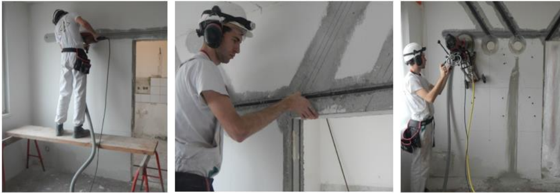
Obr. 4.13 Zesilování konstrukce pomocí helikální výztuže[10]
