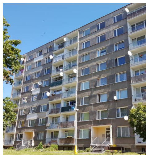
Obr. 2.6 Čelní pohled na panelový dům soustavy T06BU v Ústeckém kraji [3]
