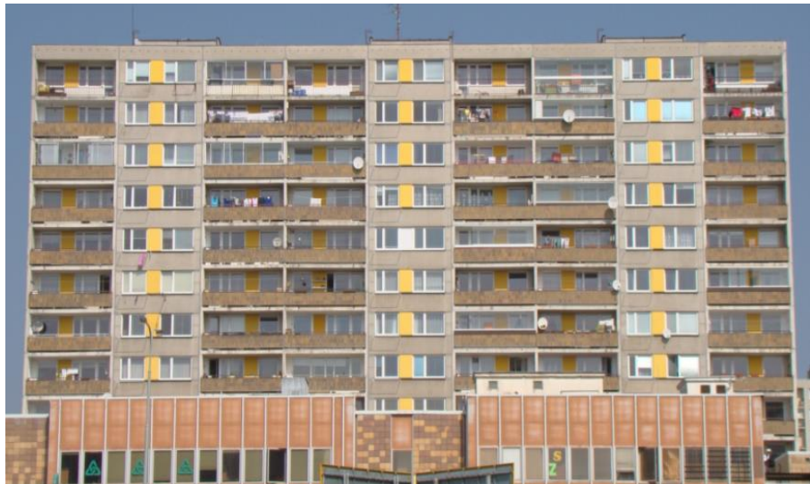
Obr. 2.9 Čelní pohled na panelový dům soustavy VVÚ-ETA [2]
