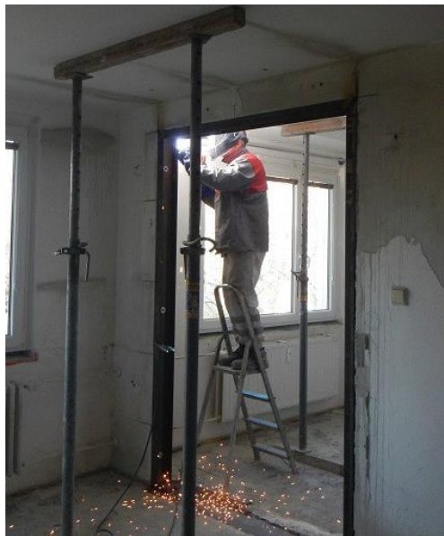
Obr. 4.15 Ztužení otvoru pomocí ocelového rámu [10]
