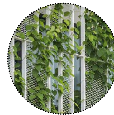
kovová konstrukce s vegetací
