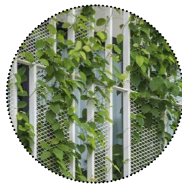
kovová konstrukce s vegetací
