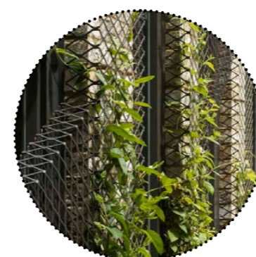
kovová konstrukce s vegetací
