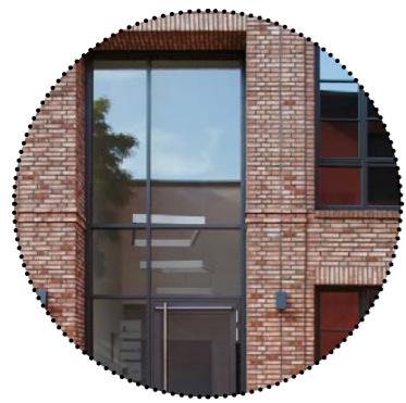
zvýraznění schodiště ve vnitrobloku
