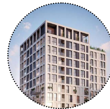
pergolová konstrukce v posledním NP
