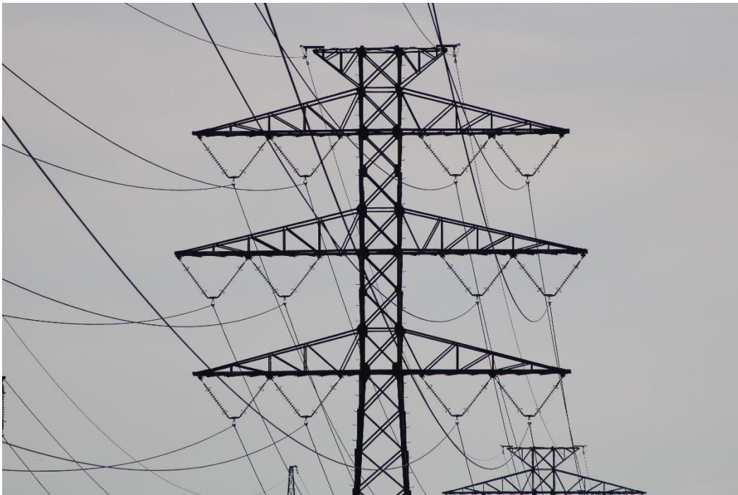
Obrázek 38: Nosný stožár typu Vertikál s nosnými V-závěsy
