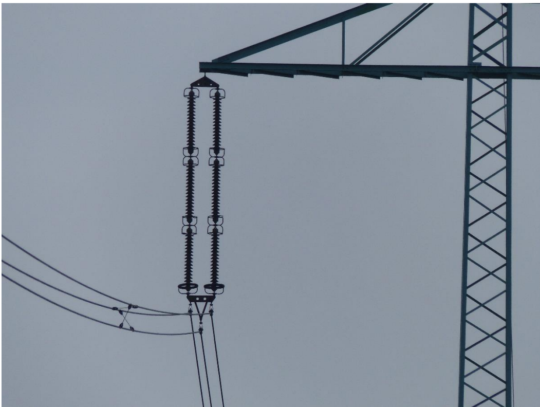
Obrázek 37: Detail dvojitého nosného izolátorového závěsu s jednobodovým uchycením
