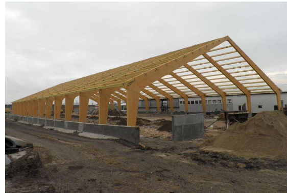
Obrázek 16 - dřevěná rámová hala [27]
