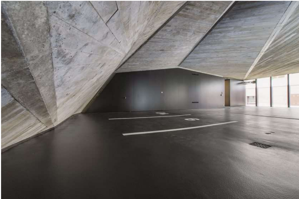
Obrázek 23 - tvarově náročná stropní monolitická konstrukce haly [30]
