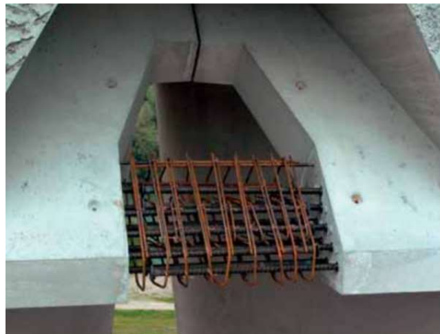
Obrázek 36 - diagonální panel v rámovém rohu [16]
