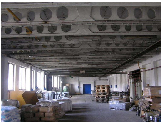
Obrázek 11 - ŽB Vierendeelův vazník [23]
