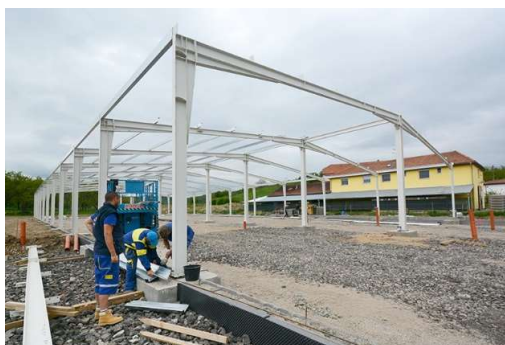
Obrázek 10 - ocelový IPE vazník [22]
