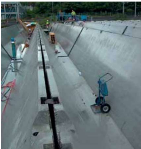
Obrázek 35 - spojení střešních vazníků [16]
