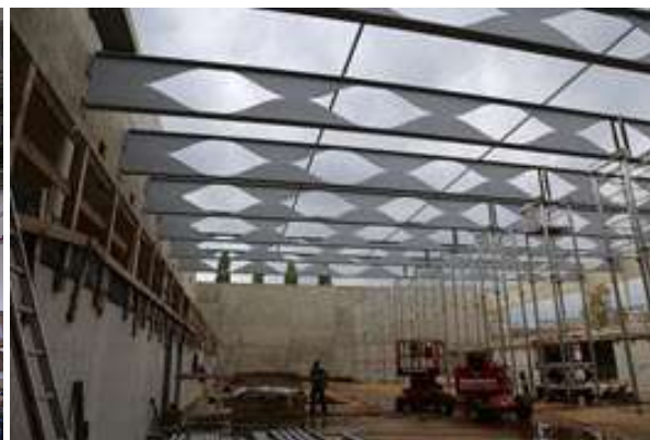
Obrázek 12 - ocelový prolamovaný vazník [24]
