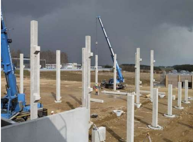
Obrázek 24 - manipulace ŽB sloupem pomocí roubíku [31] Obrázek 25 - schéma ŽB sloupu s roubíkem
