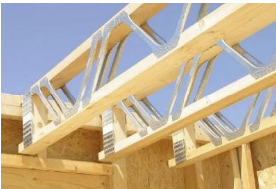
Obr. 5 - Dřevěné pásnice s ocelovými diagonálami [21]
