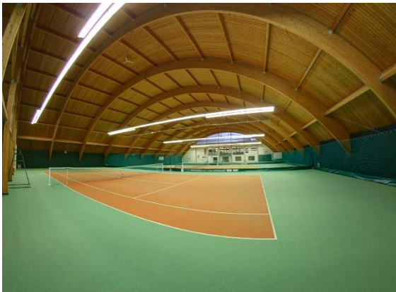
Obr. 37 - Plnostěnný obloukový vazník z lepeného lamelového dřeva [38]
