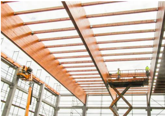
Obr. 3 - Dřevěný plnostěnný vazník [19]
