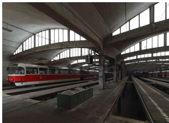
Obr. 44 - Konstrukce zastřešení tramvajového depa v pražském Hloubětíně [15]
