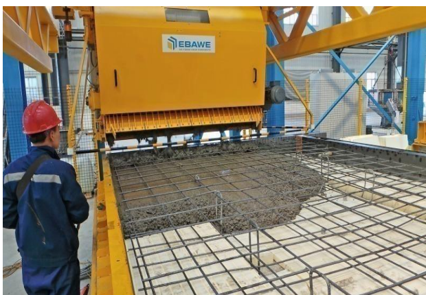
Obr. 47 - Betonáž prefabrikátů ve výrobnách [44]
