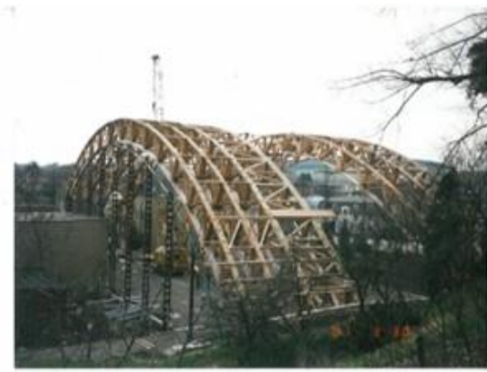
Obr. 38 - Příhradový obloukový dřevěný vazník [39]
