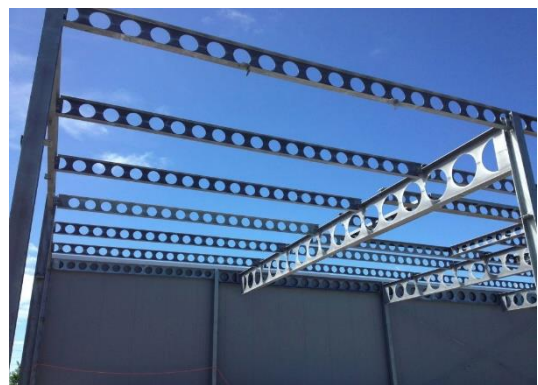
Obr. 8 - Ocelový prolamovaný vazník [23]
