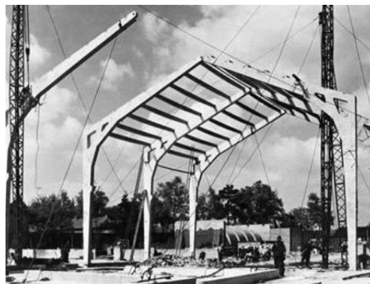
Obr. 28 - Betonová rámová konstrukce [30]
