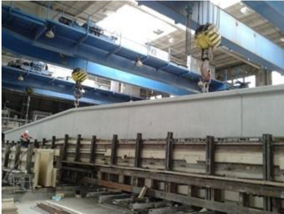
Obr. 51 - Zvedání prvku z bednění pomocí portálových jeřábů [26]
