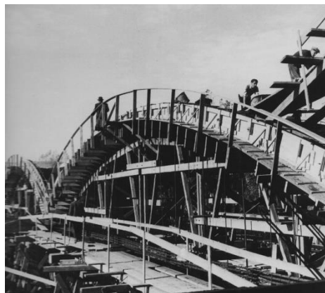
Obr. 46 - Bednění železobetonových monolitických oblouků [15]
