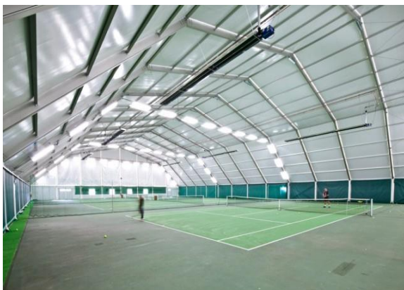
Obr. 39 - Plnostěnný obloukový vazník z ocelových válcovaných profilů [40]
