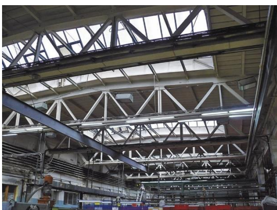
Obr. 13 - Betonový příhradový vazník [28]
