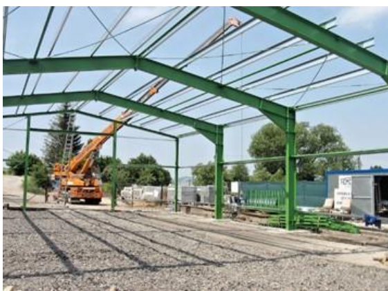
Obr. 25 - Plnostěnný ocelový rám [32]
