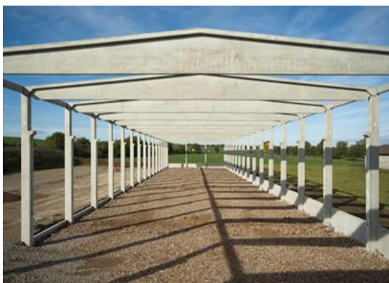
Obr. 11 - Betonový plnostěnný vazník [26]
