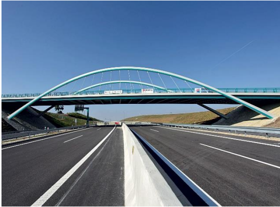
Obr. 35 - Stabilizace oblouku smykovým spolupůsobením s mostovkou [36]
