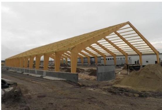
Obr. 23 - Plnostěnný dřevěný rám [30]
