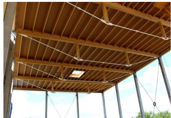
Obr. 6 - Dřevěný nosník s ocelovým táhlem [22]
