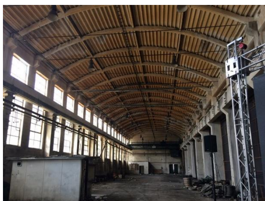
Obr. 14 - Betonový obloukový vazník [29]
