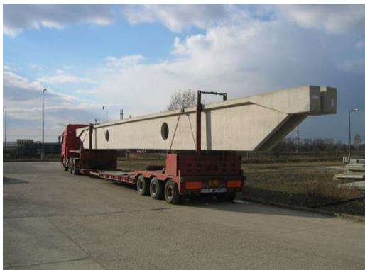
Obr. 68 - Transport dvou vazníků délky 24 metrů [50]
