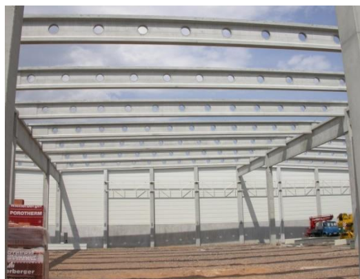
Obr. 12 - Betonový prolamovaný vazník [27]
