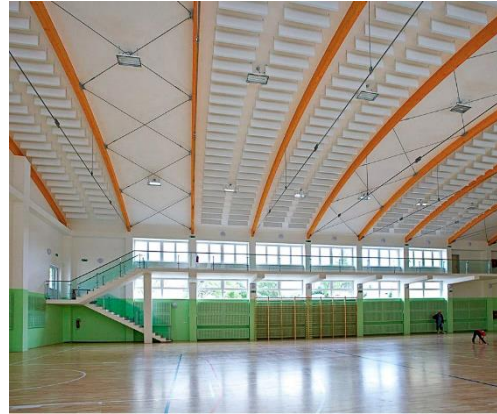
Obr. 36 - Stabilizace obloukové konstrukce pomocí ztužidel [37]
