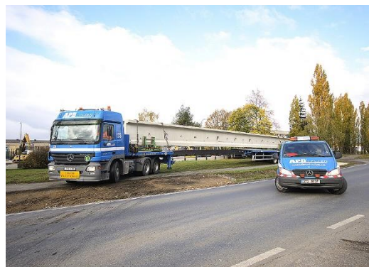
Obr. 69 - Transport vazníku délky 28 metrů [46]
