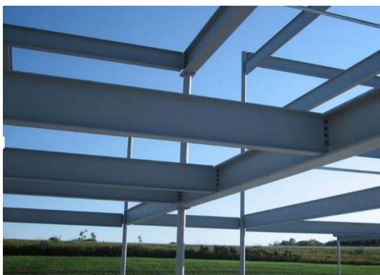
Obr. 7 - Ocelový plnostěnný vazník [23]
