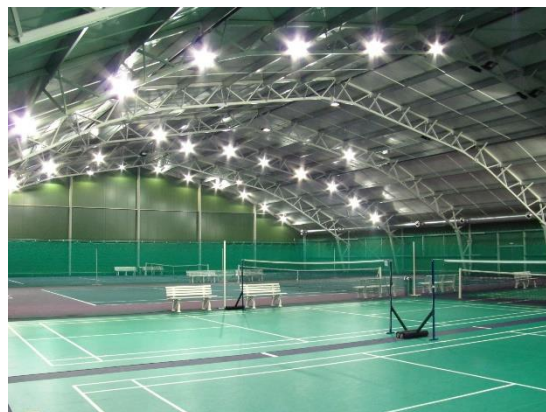
Obr. 40 - Příhradový obloukový ocelový vazník [41]
