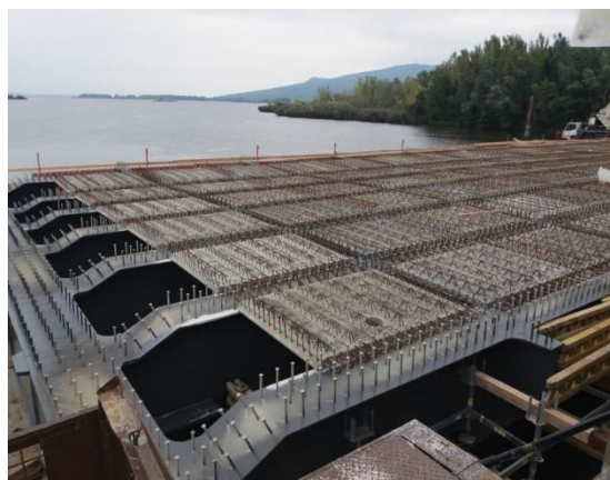
Obr. 50 - Prefabrikované konstrukce před zmonolitněním betonem [45]
