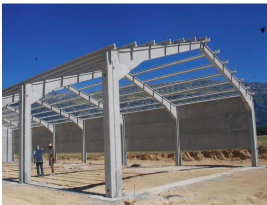
Obr. 27 - Betonová rámová konstrukce [34]
