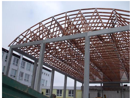
Obr. 4 - Příhradový vazník - celodřevěný [20]
