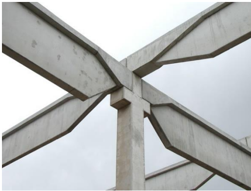
Obr. 64 - Kombinace uložení nosníků na ozub a vazníků na zhlaví sloupu [50]
