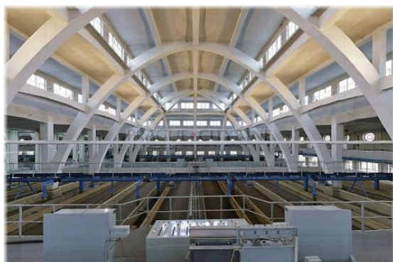
Obr. 41 - Plnostěnný rovinný železobetonový oblouk - Podolská vodárna [42]
