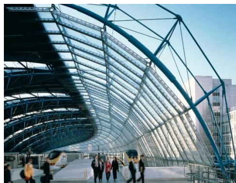
Obr. 34 - Stabilizace obloukové konstrukce pomocí ocelových táhel [35]
