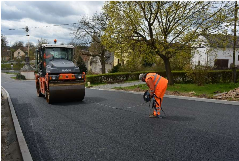
Obrázek 15 - Firma Froněk – hutnicí a dokončovací práce
