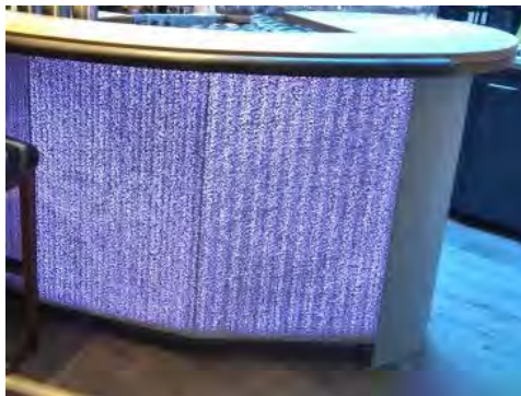
Obrázek 22: Příklad obložení panely z průsvitného betonu [37]
