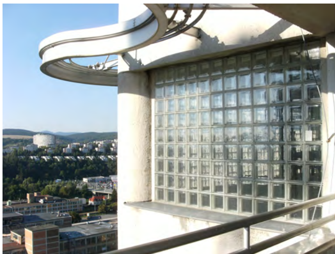
Obrázek 1: Výplň otvoru sklobetonem [3]
