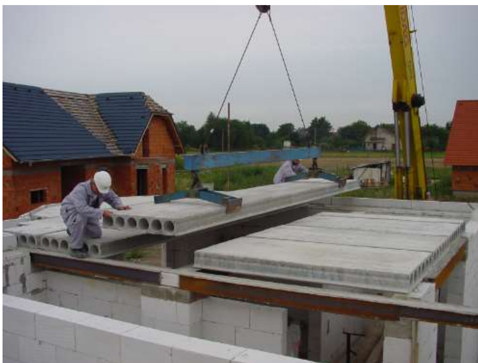
Obrázek 5 - Využití prefabrikovaných předpjatých stropních panelů [22]
