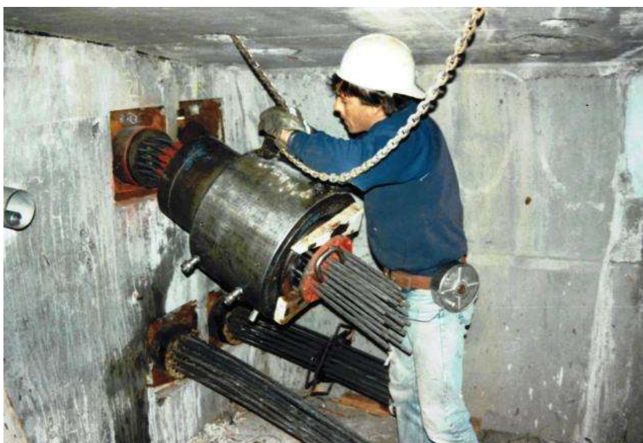
Obrázek 4 - Technologie dodatečně předpjatého betonu – provedení předpětí na stavbě [21]
