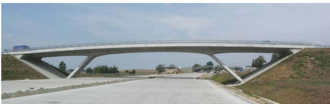
Foto 12 – Silniční nadjezd nad rychlostní komunikací R35 (zdroj [6])
