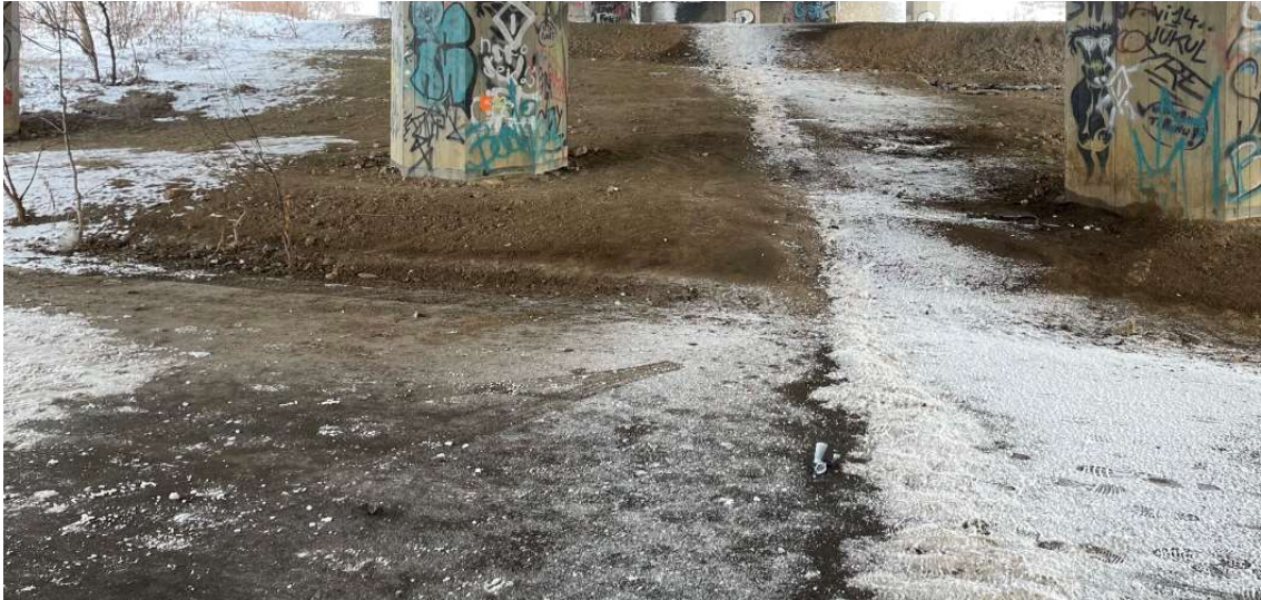
Obrázek 96 – Povrch západní strany lávky (foto autora)
