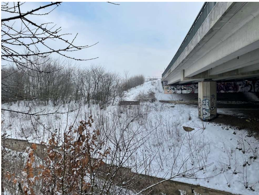
Foto 5 – Jižní strana trati (foto autora)
