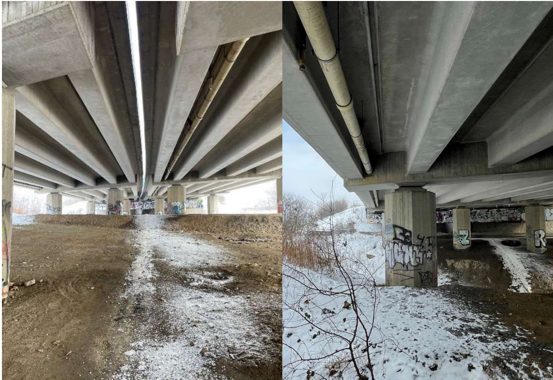
Foto 9 – Pohled na nosnou konstrukci přilehlého silničního mostu (foto autora)
