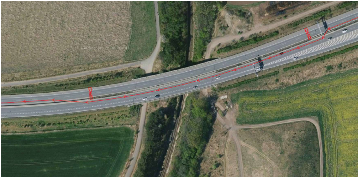
Obrázek 90 – Náhradní trasa při uzavření poloviny mostu (zdroj [24])
