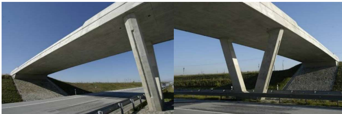
Obrázek 16 – Koncová opěra a V stojka nadjezdu nad rychlostní komunikací R35 (zdroj [6])
