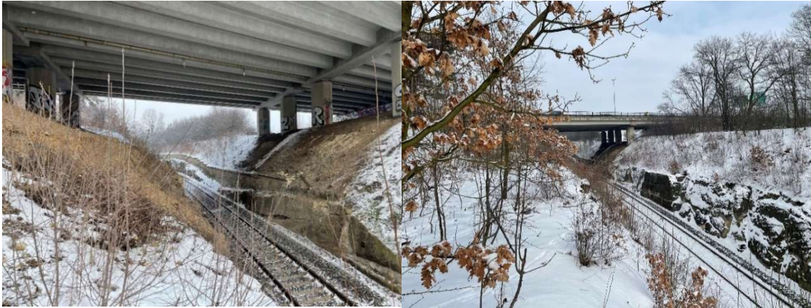
Foto 6 – Pohled na zájmové území ze strany Černého Mostu, lávka umístěna z našeho pohledu za mostem (foto autora)
