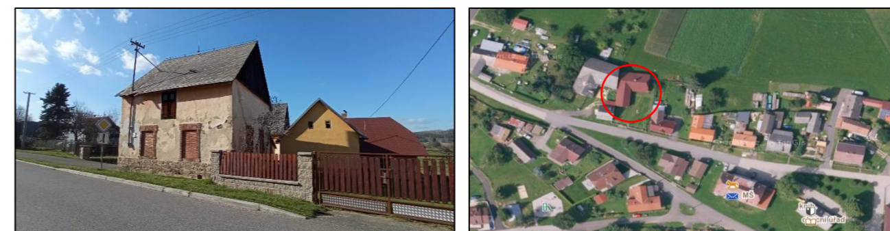
Obrázek 58 a 59 – nevhodně umístěna stavba narušující stavební čáru [32]
