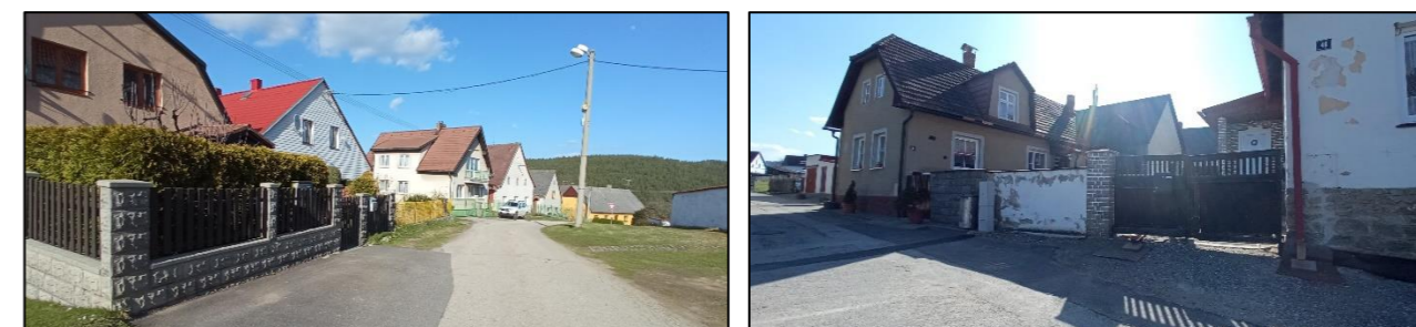
Obrázek 50 a 51 – nevhodně zvolená kombinace oplocení
