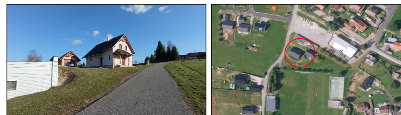
Obrázek 60 a 61 – nevhodně exponované umístění stavby [32]
