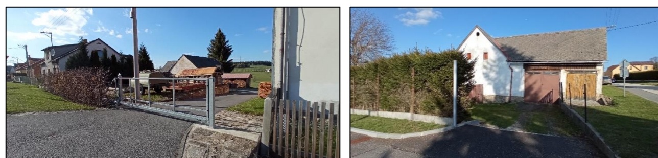
Obrázek 54 a 55 – nevhodně zvolená kombinace oplocení a jeho nedokončení
