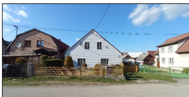
Obrázek 68 – nevhodná plastová fasáda stavby
