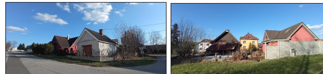
Obrázek 48 a 49 – nevhodně zvolená kombinace oplocení
