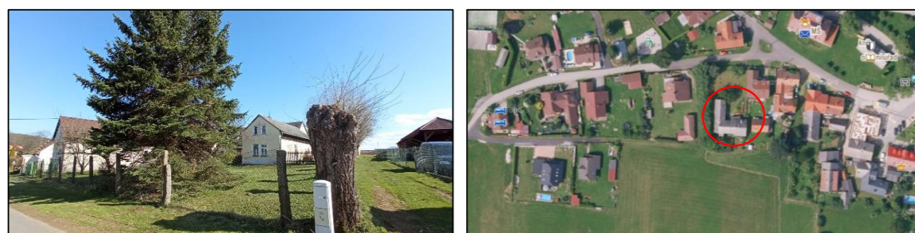
Obrázek 56 a 57 – nevhodně umístěna stavba narušující stavební čáru [32]
