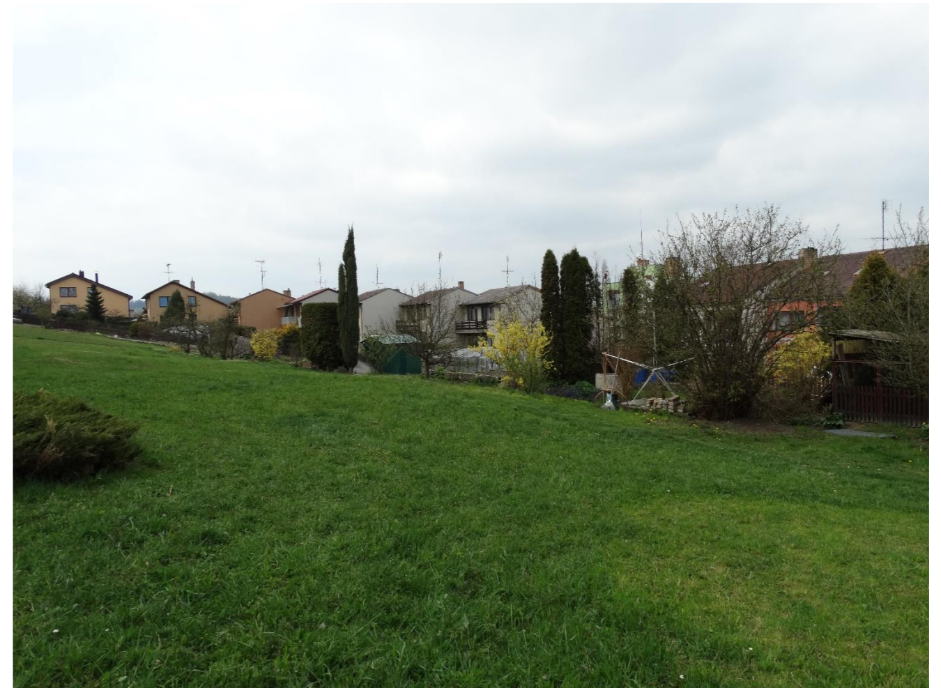
Obrázek 42: Nevhodný přechod mezi soukromým a veřejným prostorem (Řezáč, 2021)
