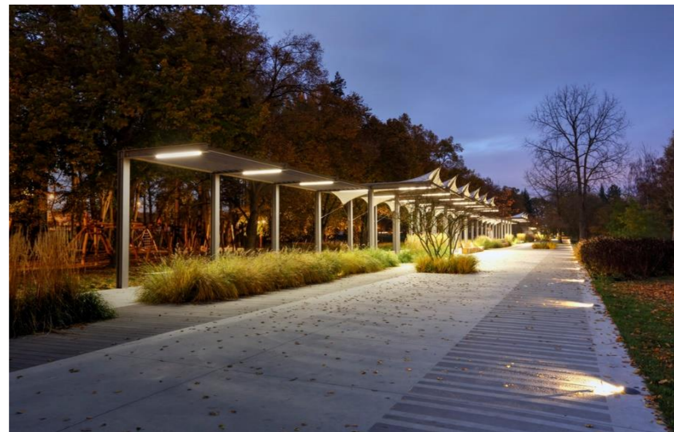
Obrázek 55: Přístřešek v Tyršových sadech v Pardubicích (Stavba roku, 2017)
