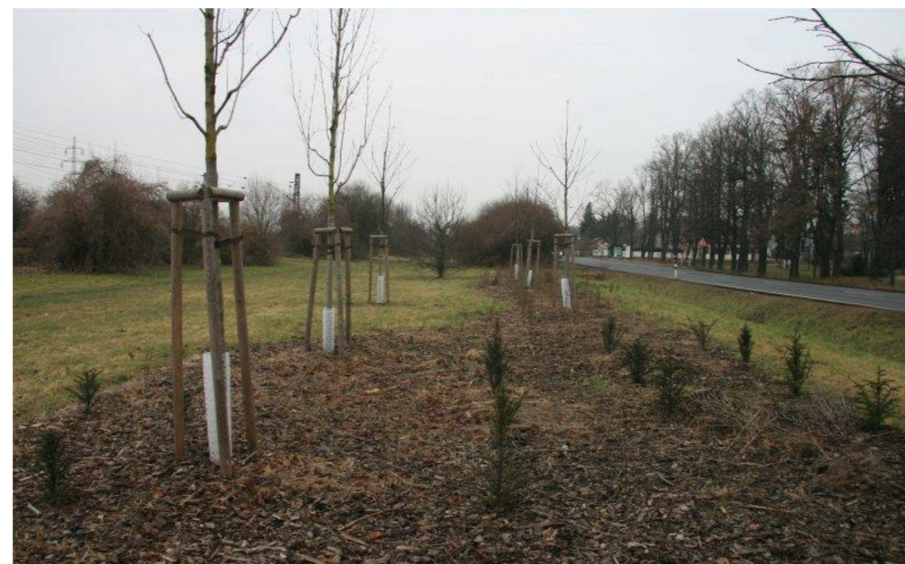
Obrázek 57: Výsadba izolační zeleně kolem komunikace (Jebavý, 2015)
