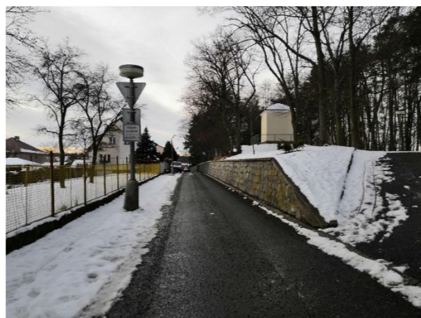
Obrázek 28: Pozemní komunikace v ulici Na Hůrkách (Řezáč, 2021)
