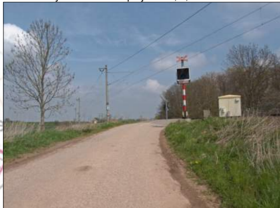
Křížení trasy s železničním přejezdem, 5.8. km
