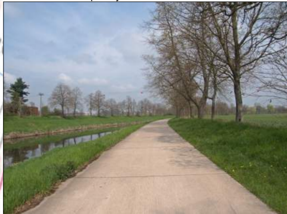
Povrch - betonové panely
