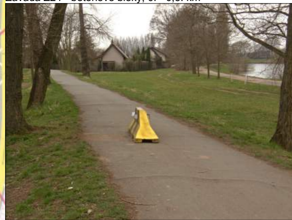
Závada Z24 - betonové bloky, 0. - 0,5. km
