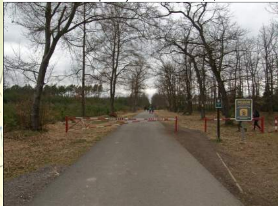
Závada Z24 - závora proti vjezdu automobilů, 6,1. km
