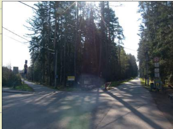
Závada Z26 - křížení s účelovou komunikací, 0,7. km
