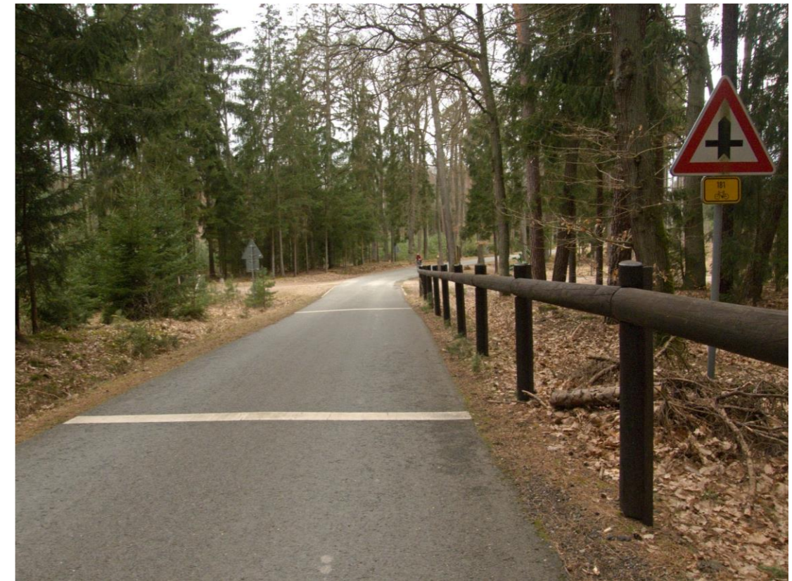
Obrázek 37: Odkazovaná dřevěná konstrukce (sjezd s 12% sklonem, Hradečnice), (Zdroj: vlastní fotografie)
