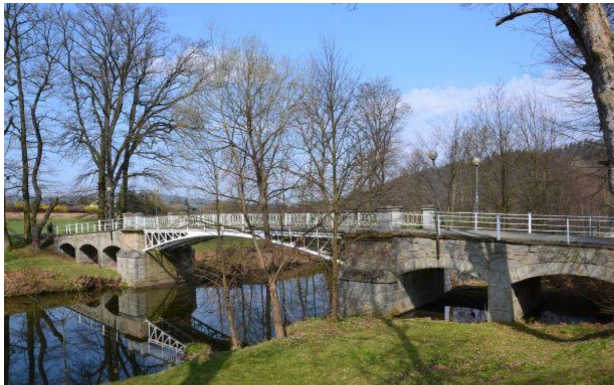
Obrázek 27: Inundační litinový most u zámku Kozel, Autor: K. Fryčková
