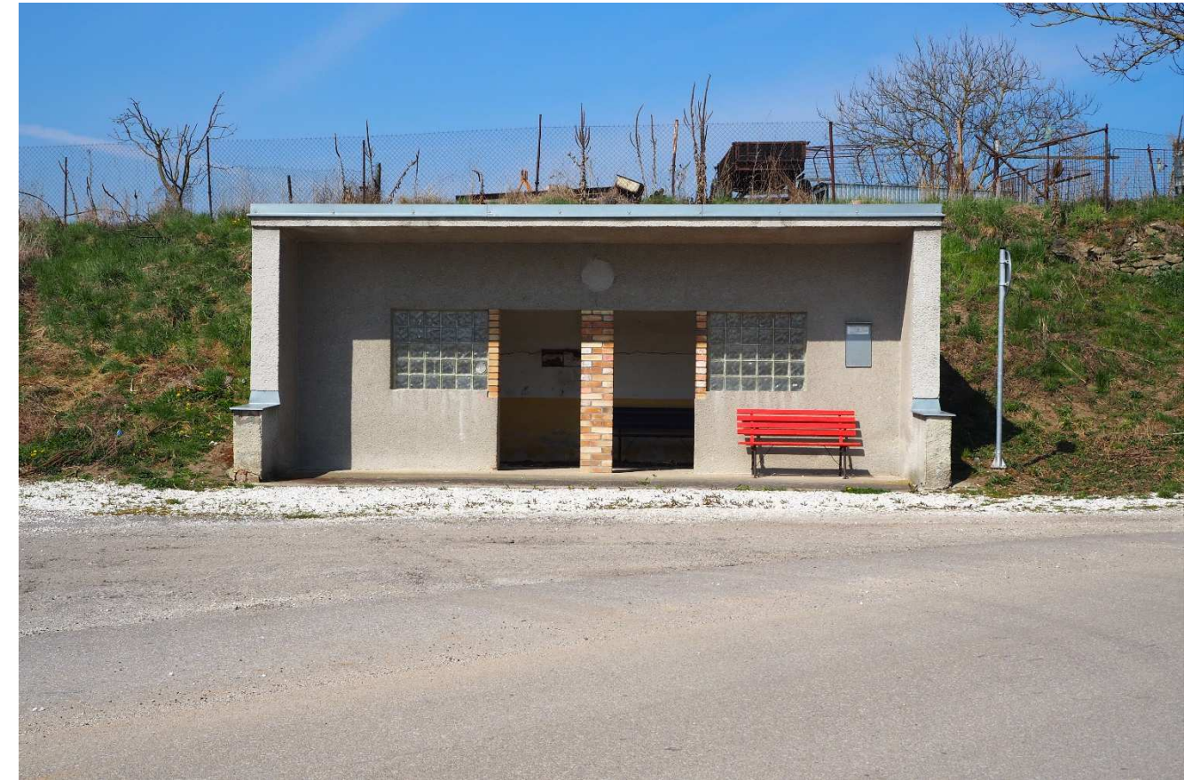
9 Zastávka autobusové dopravy
