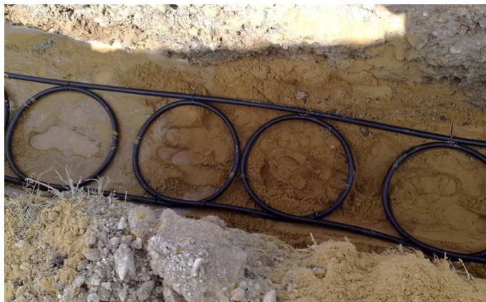
Obrázek 2.2. Ukázka výparníku- zemní kolektor pro tepelné čerpadlo země-voda [4]
