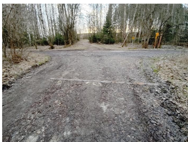
Obrázek 95: základy brány signální stěny zdroj: foto autorky 2021
