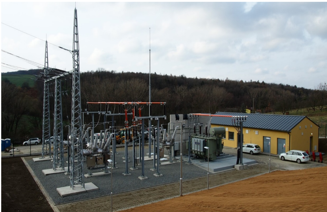
obr. č. 2.2 Částečně zapouzdřená rozvodna [16]
