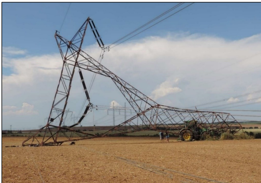
Obrázek 11: Nehoda traktoru se stožárem 26
