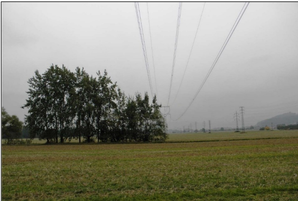
Obrázek 6: Vysoký porost pod vodiči vedení ZVN 21
