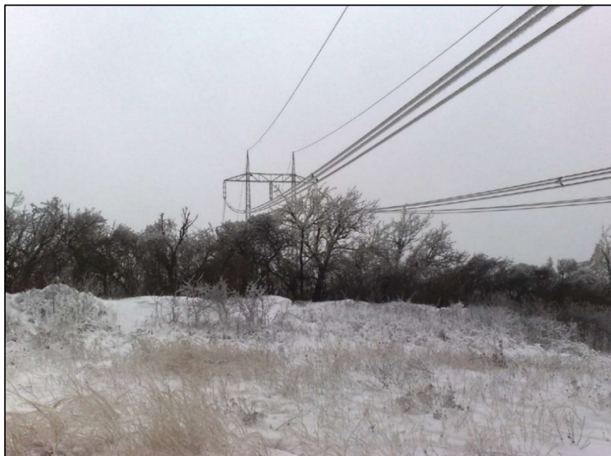
Obrázek 12: Velká námraza na fázových vodičích 27
