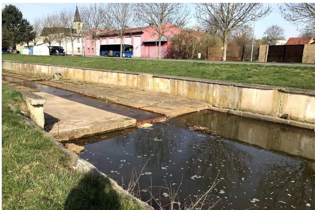
Obrázek 3: Upravené koryto vodního toku v intravilánu
