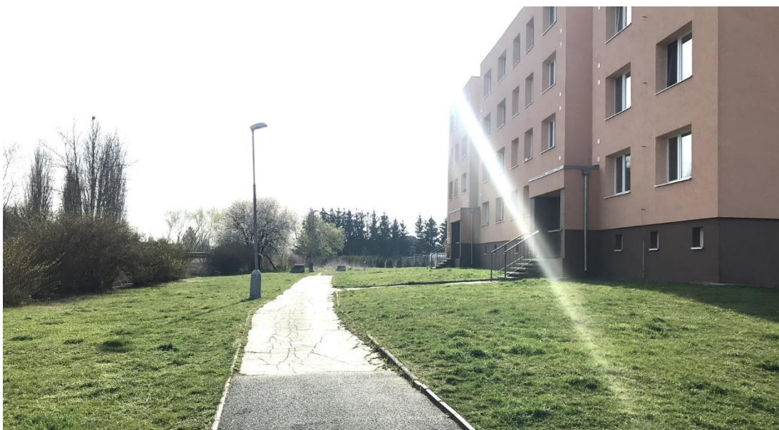
Obrázek 9: Panelový dům v blízkosti toku
