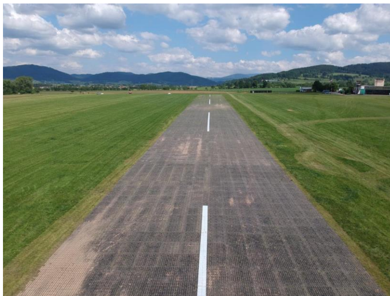
Obr. 13: Zatravňovací dlaždice pár dní po instalaci - letiště Šumperk
