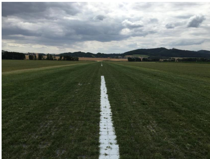
Obr. 14: Zatravňovací dlaždice dva měsíce po instalaci - letiště Šumperk
