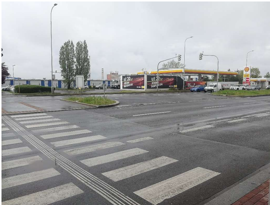
Obrázek 9- křižovatka Průmyslová x Spalovna, pohled z ulice Průmyslová směr sever
