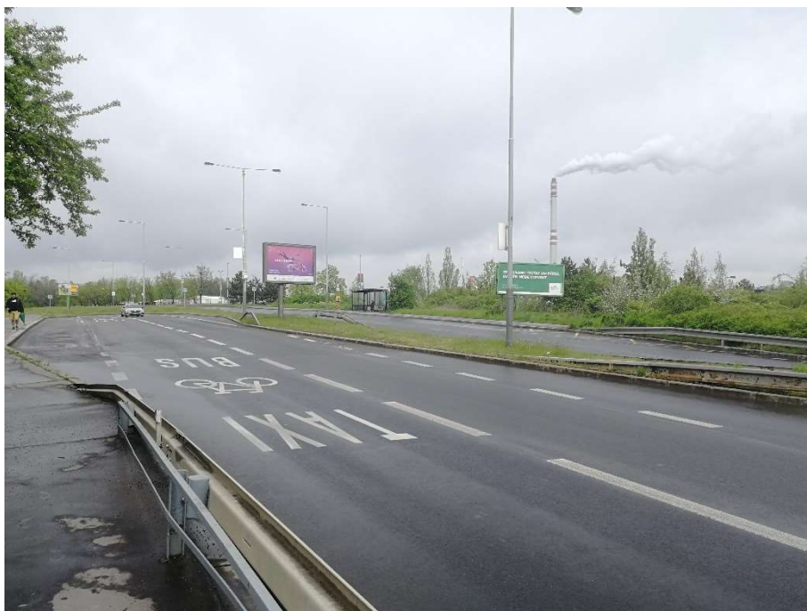
Obrázek 4 - pohled na autobusovou zastávku Průmyslová, z ulice Černokostecká
