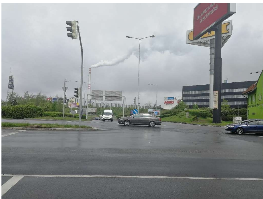
Obrázek 2- křižovatka Černokostecká x rampa Štěrboholy, pohled na rampu
