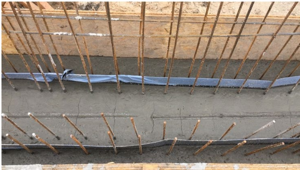
Obr. 16 – těsnění pracovní spáry těsnícími plechy
