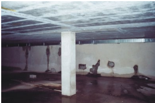
Obr. 23 – nová podzemní podlaží
