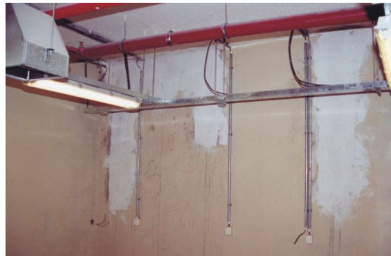
Obr. 26 – sanace těsněných spár
