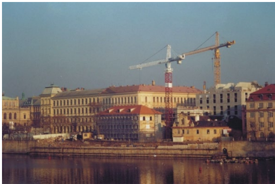
Obr. 25 – pohled na budovu ve výstavbě
