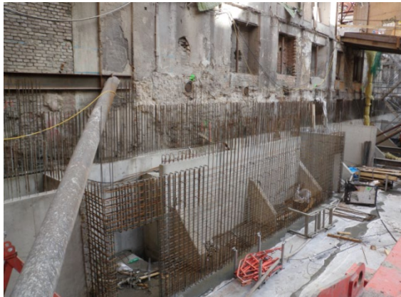
Obr. 27 – obvodové stěny 1. PP
