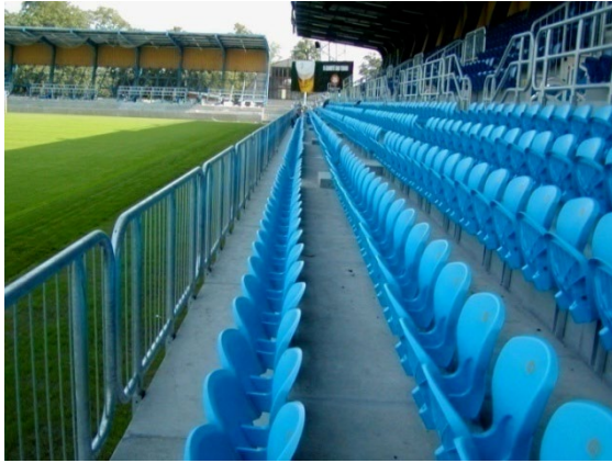
Obr. 31 – pohled na konstrukci tribuny
