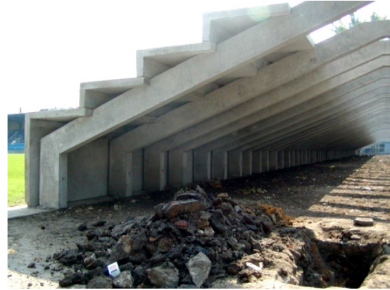
Obr. 32 – pohled na konstrukci tribuny
