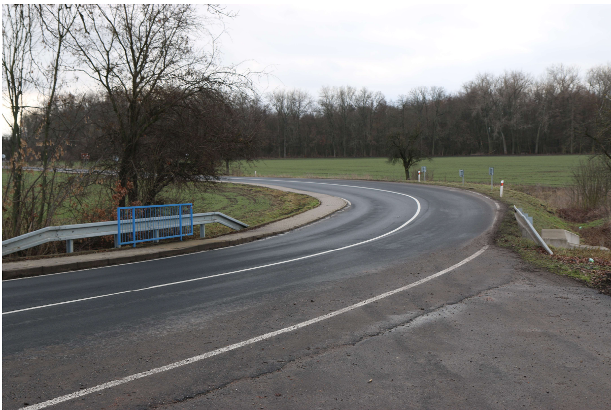
Foto č. 3 – Nedostatečný poloměr směrového oblouku
