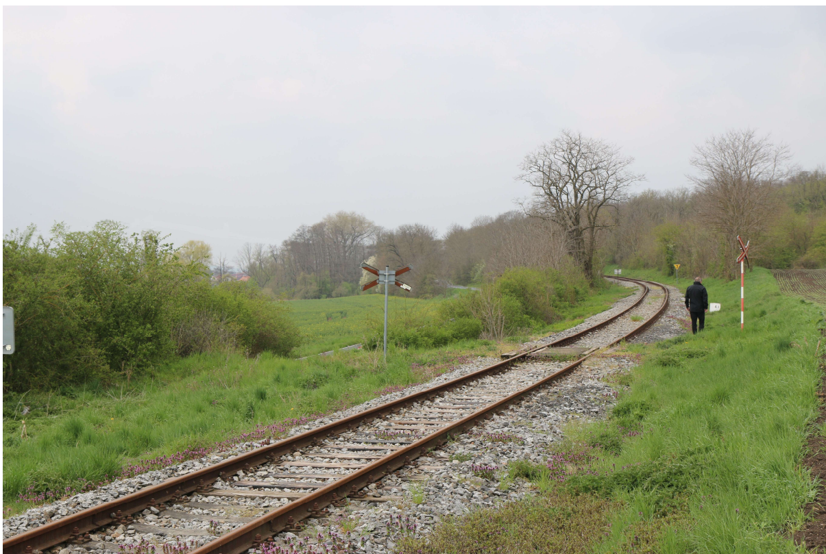
Foto č. 11 - Místo přemostění železniční tratě č. 095
