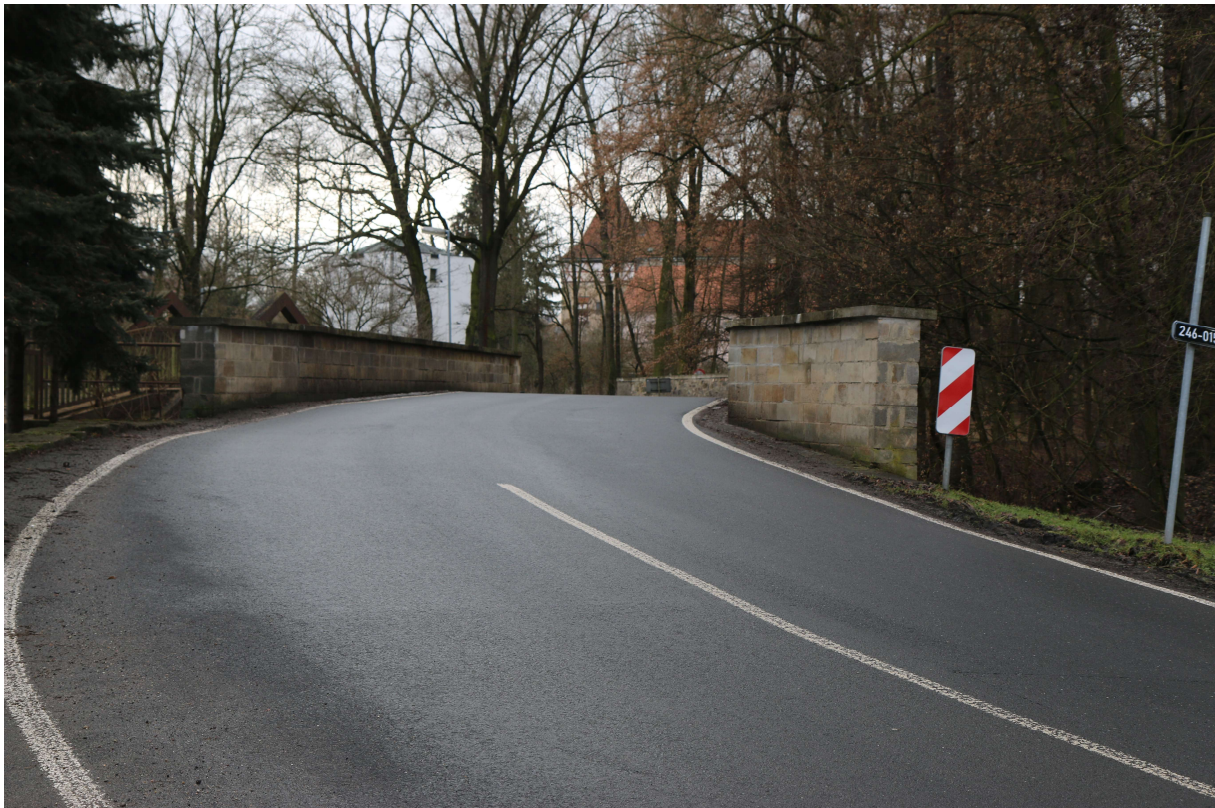
Foto č. 1 – Malá šířka komunikace mostu přes Malou Ohři
