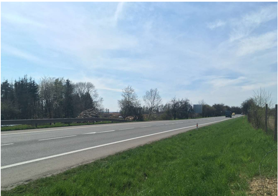
Obrázek 18: pohled na konec Variant 0, 2, 3, 6 i 7, pohled proti staničení
