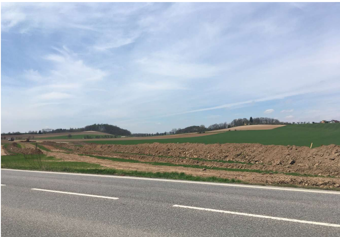
Obrázek 14: místo křížení Varianty 0 se stávající I/33 (bude zde zrušena), pohled proti směru staničení
