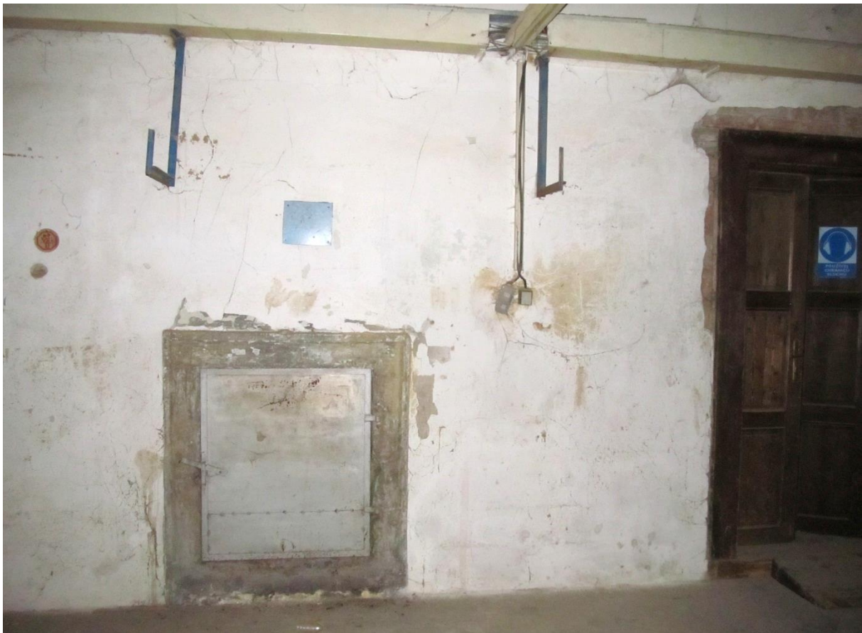
Foto 16 Původní příkladací dvířka s kamenným ostěním, snímek z hlavní chodby severního křídla, vpravo dveře do 1.14 (dvířka lze vidět i na snímku u kapitoly o záchodech)
