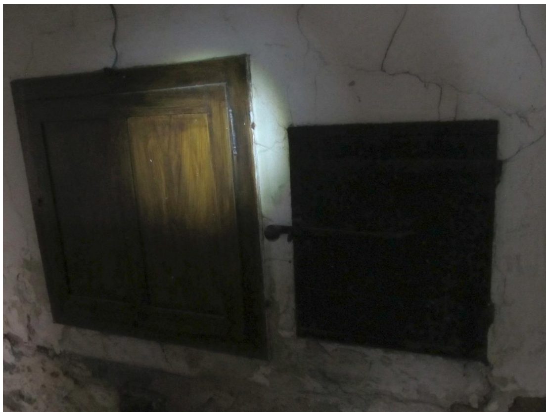
Foto 11 Příkládací dvířka v chodbě JZ křídla, vedle F.1.4
