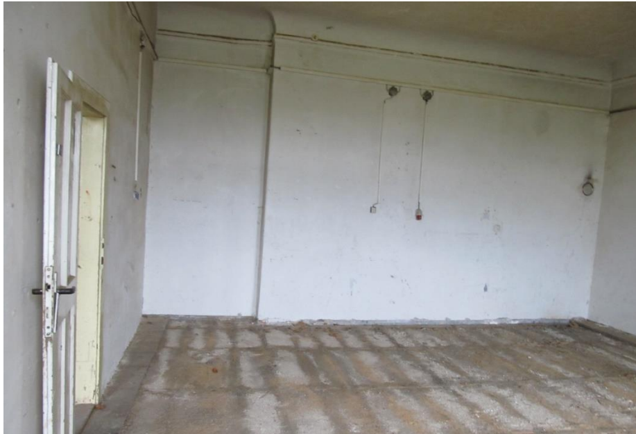
Foto 24 Jedna z místností za věží (2.13) - ač je zde ozub od zdi věže, nejsou zde znatelné stopy po předělení místnosti, strop i fábion jsou celistvé; vlevo novodobá příčka
