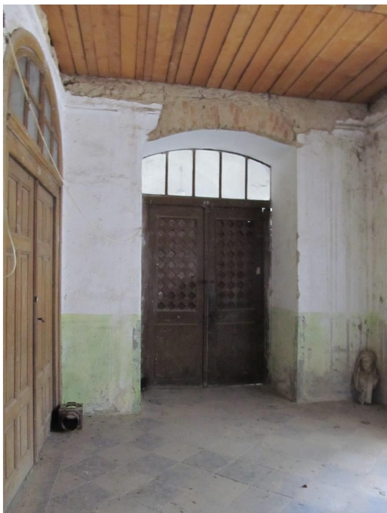
Foto 35 Průchod do J části patra stř. křídla - bytu faráře; oddělení dveřmi s průřezy a secesním nadstvětlíkem – modifikované
