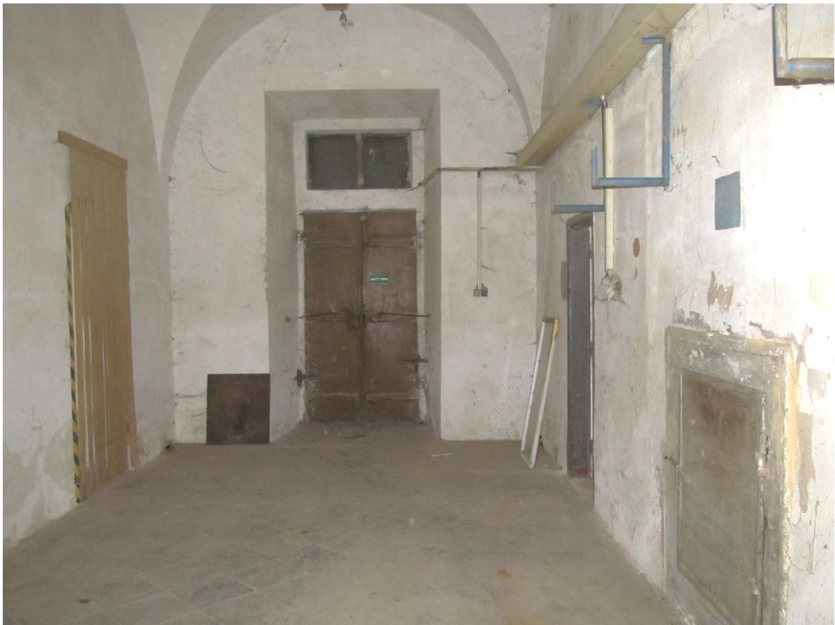
Foto 21 Pohled na severní konec chodby středního křídla, v čele dveře s nadsvětlíkem, původně venkovní, dveře pravděpodobně původní; nalevo novodobý průraz do 1.18, vpravo vstup do 1.15, zcela vpravo původní dvířka do komína s kamenným ostěním
