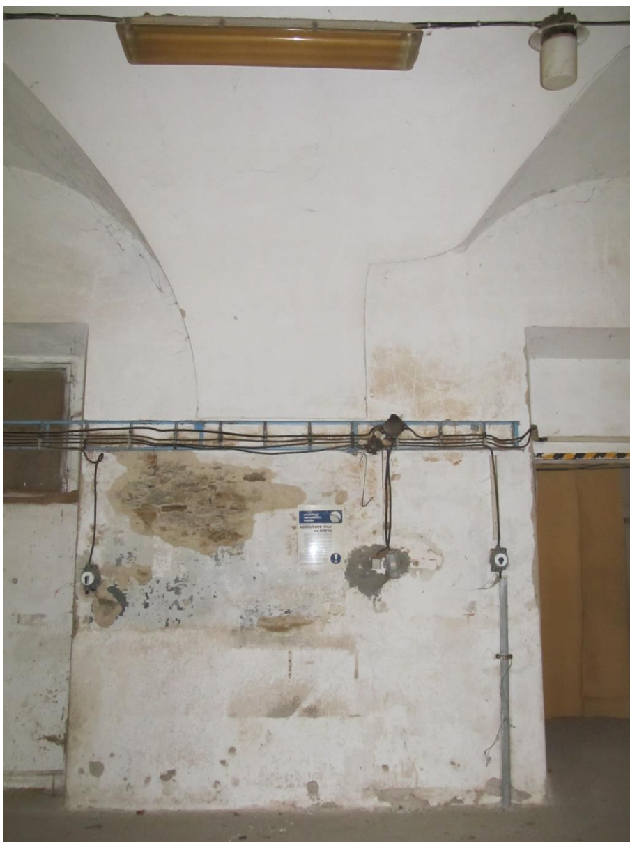
Foto 20 Pohled ze středu místnosti na zed' mezi nikou s oknem a dveřním otvorem, na první pohled je viditelná podobnost formátu, což naznačuje, že vlevo mohly být dříve místo okna dveře; uprostřed je vidět vykrojení u paty klenby v pravé polovině
