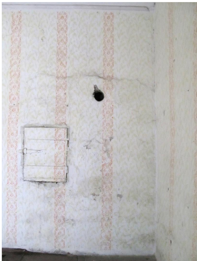
Foto 32 Příkládací dvířka na chodbě před byty 2.18
