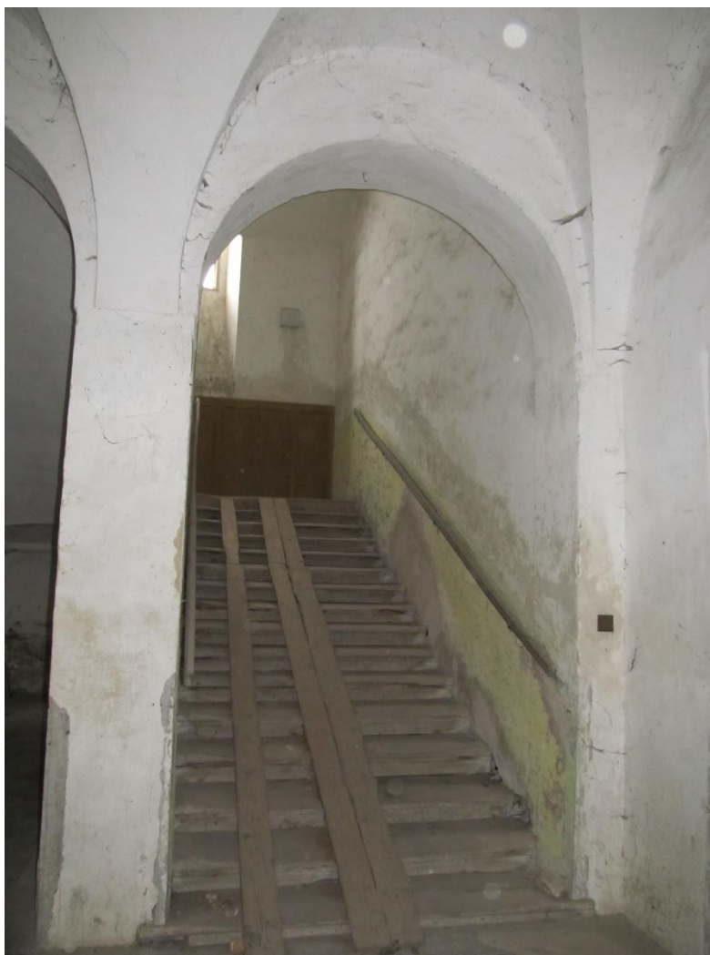
Foto 27 Hlavní schodiště z přízemí do patra, pohled z přízemí
