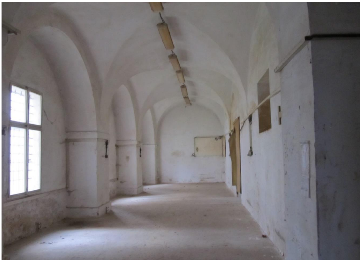
Foto 28 Pohled na chodbu SZ křídla směrem od křižení s chodbou středního křídla; vlevo viditelné zazděné arkády
