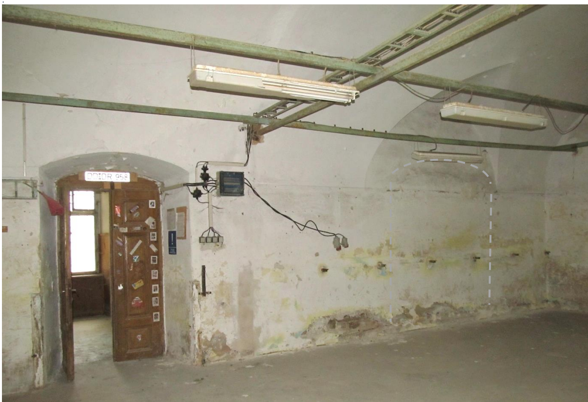
Foto 7 Delší strana kuchyně (1.03) - náznak zazděného vchodu
