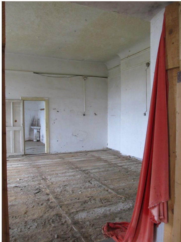
Foto 25 Záběr téže místnosti směrem na novodobou příčku, fábion pokračuje plynule za ní - znak původní celistvosti místnosti
