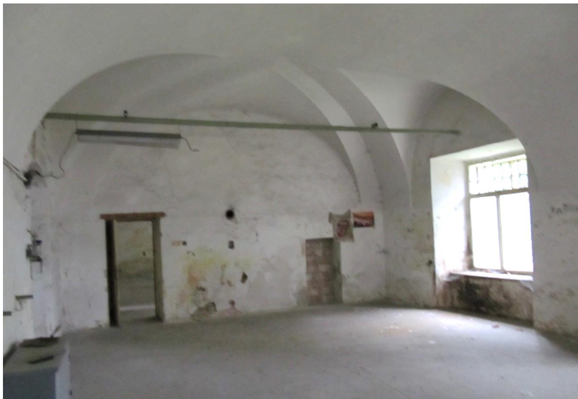
Foto 10 Dělicí zeď mezi kuchyní a refektářem 1.02, napravo domnělé zazděné podávací okénko
