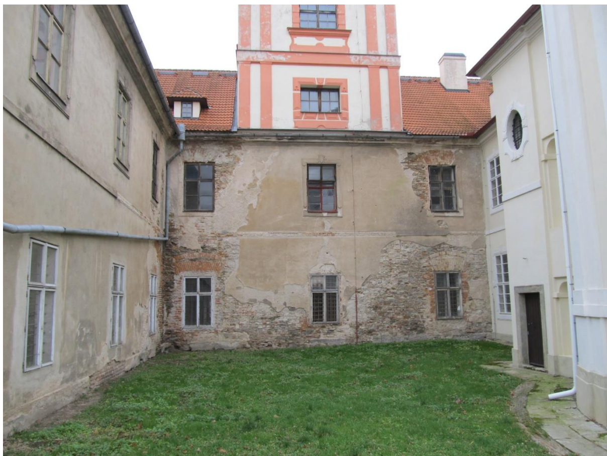
Foto 43 Pohled na severní polovině nádvoří čelem k fasádě středního křídla a věži s novou omítkou, porovnání barevnosti kláštera, kostela a věže a formátů oken
