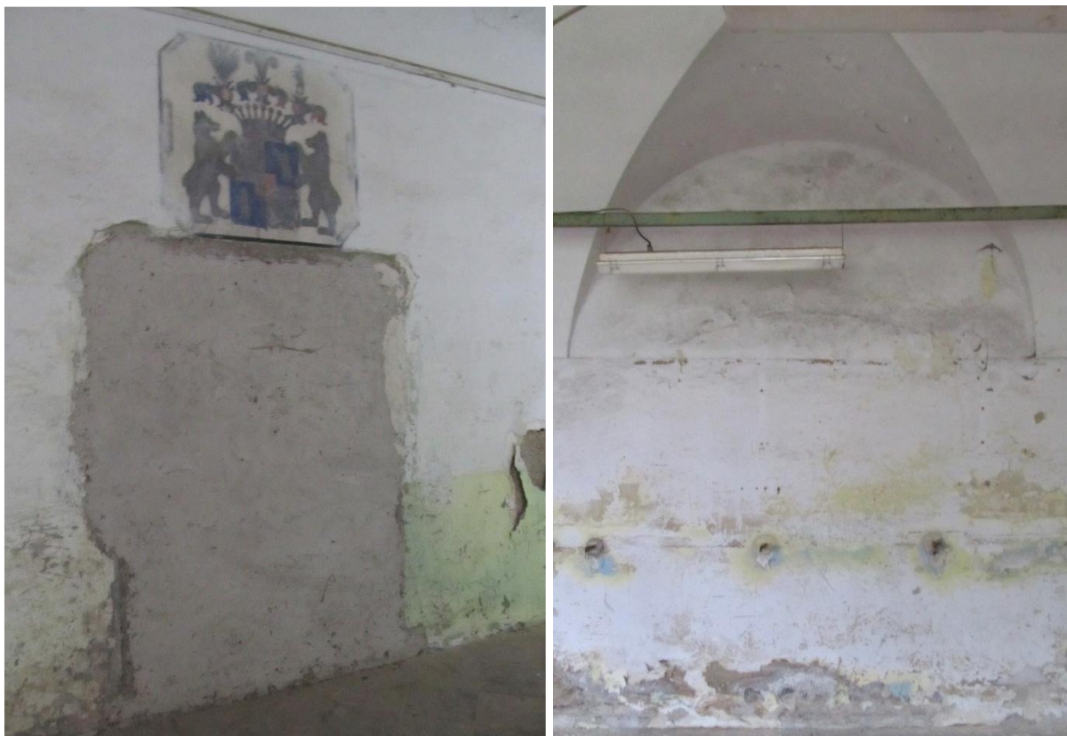
Foto 1 Zazděný průchod na kůr nad sakristií kostela, pohled ze středu chodby středního křídla
