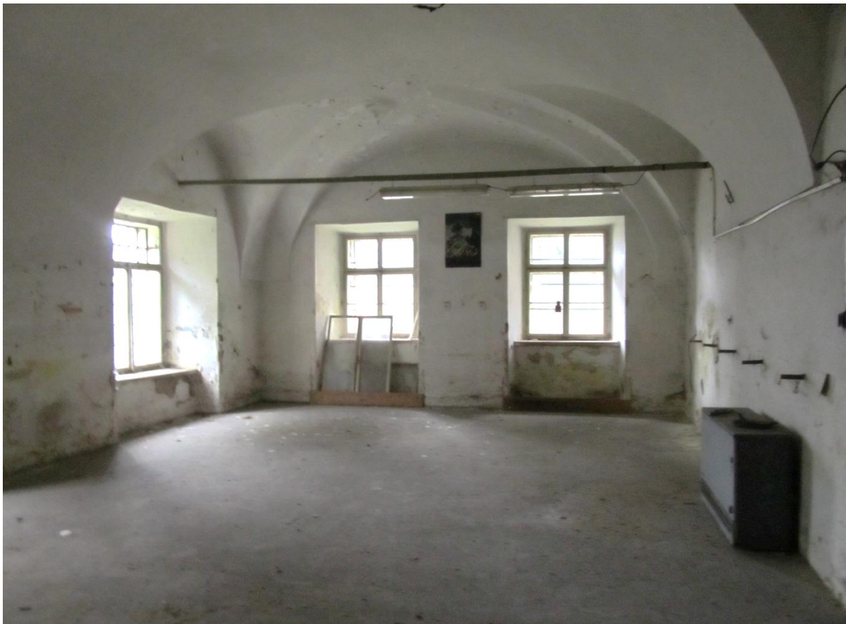
Foto 9 Pohled od vchodu čelem ke kratší stěně s okny 1.02; novodobá okna se jeví trochu širší, podlaha vybetonovaná
