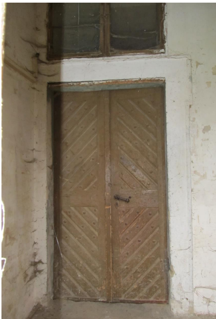
Foto 23 Tytéž dveře z vnější strany a pohled na nadsvětlik, kolem dveří jasně znatelné kamenné ostění schované pod omítkou
