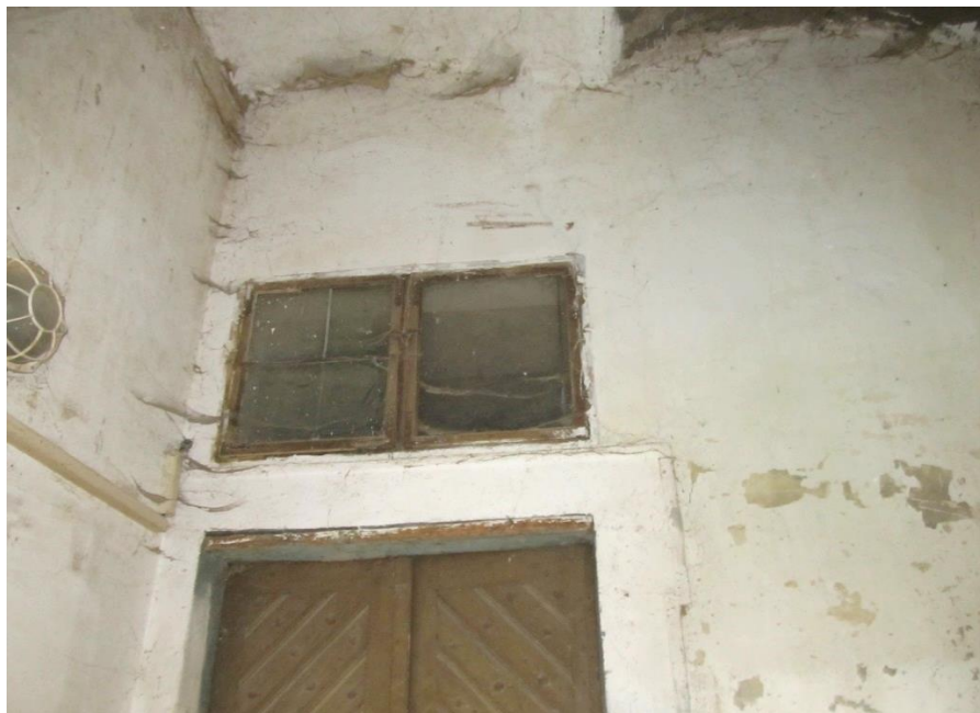
Foto 22 Pohled na nadsvětlík z vnější strany, nahoře znatelné novodobý strop s klenbičkami do traverzy
