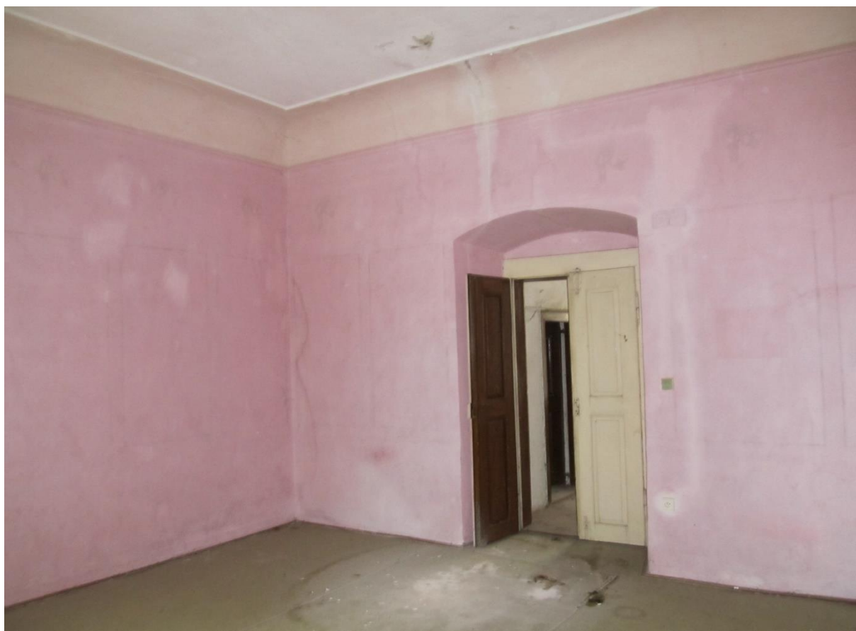
Foto 5 Místnost v patře nad průjezdem, jediná z JZ křídla s fabionem, vstupní 2-křídle dveře, pod linem možná památkově hodnotná dřev. podlaha
