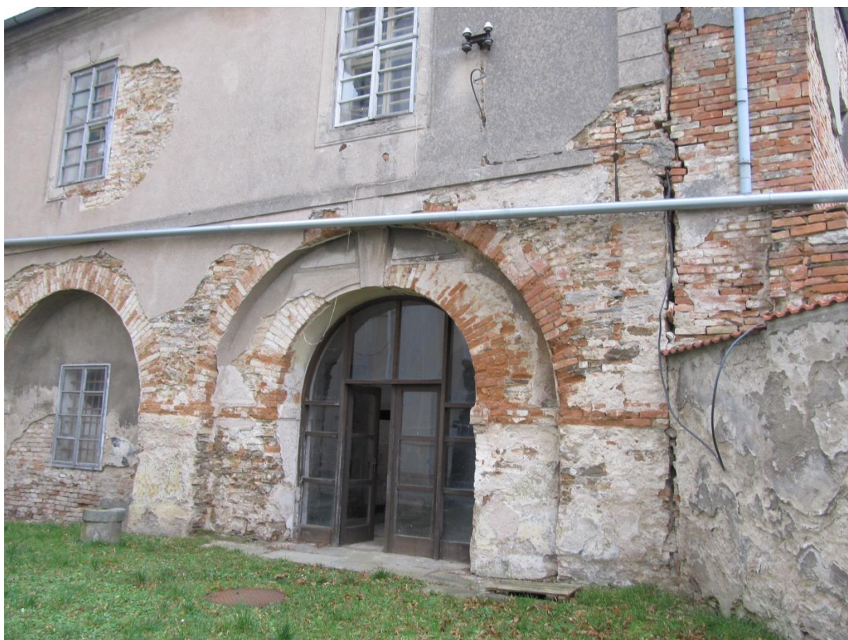
Foto 42 Pohled ze dvora na JZ křídlo, uprostřed dveře průjezdu, vlevo oblouk zazděné arkády, vpravo ohradní zeď a přístěnek
