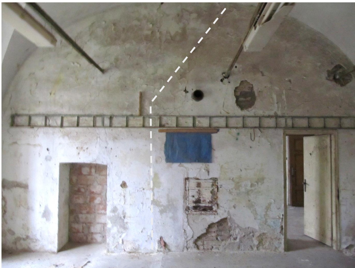
Foto 6 Pohled na kratší zeď dělicí kuchyň a refekář - možné obrysy topeniště v kuchyni, vlevo podávací okénko či průchod, vpravo novodobé dveře
