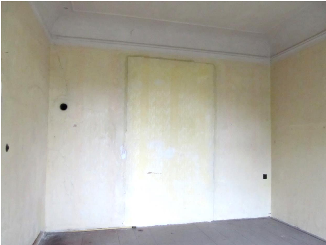
Foto 31 Zazděné dveře do bytu v 2.21, zachovalý fabion, vlevo otvor do komína; na stěnách žlutavý nátěr ze žlutým svislým dekorem
