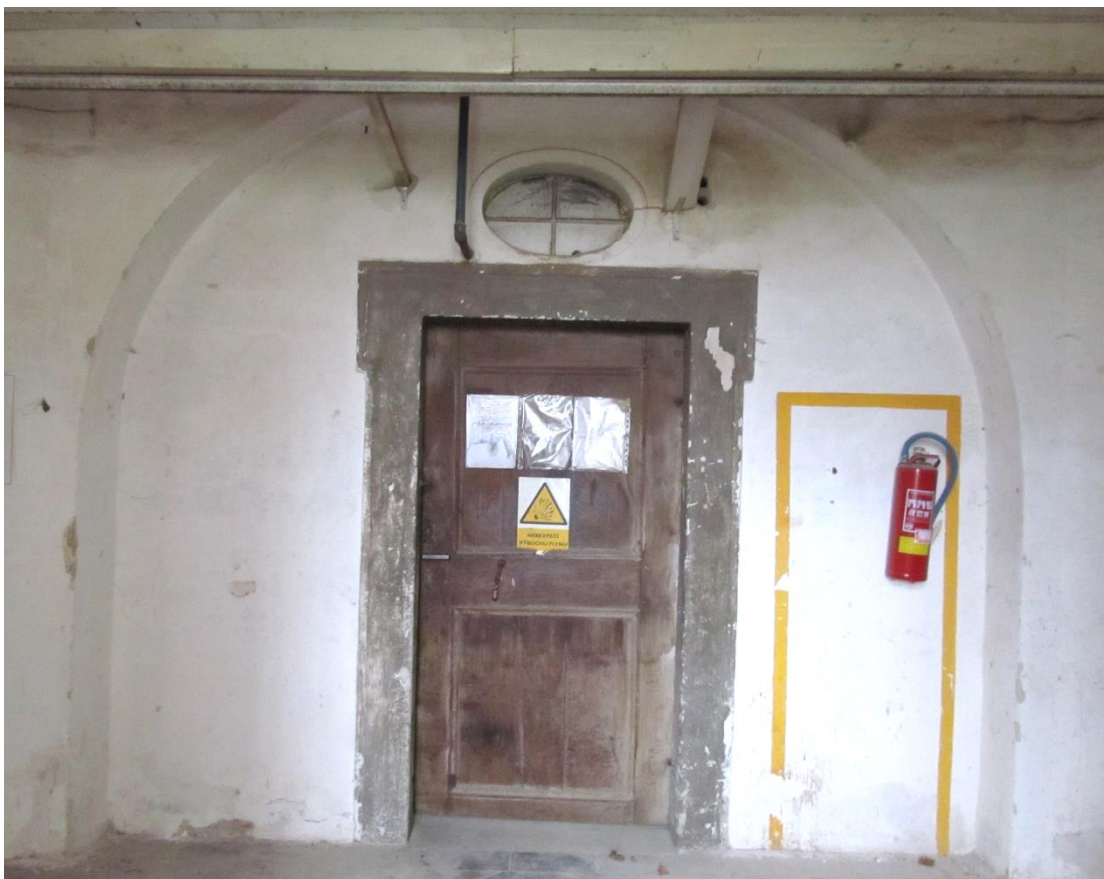
Foto 12 Dveře do místnosti s průchodem k studni, pohled z podvěží; dveře mají původní kamenný portál, kulotý nadsvětlik
