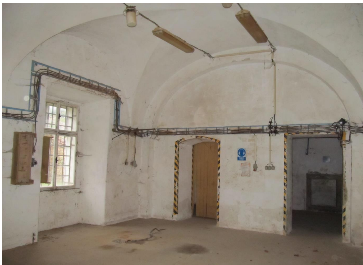
Foto 19 Pohled na probourané otvory do chodby středního křídla a jedno okno 1.18
