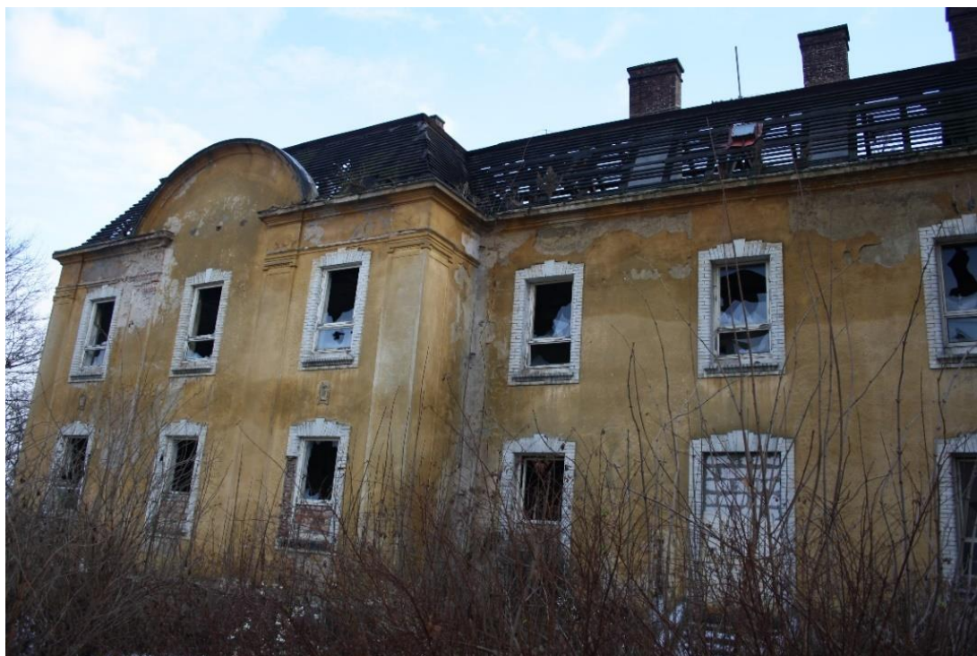
Obrázek 9 - Kasárna St. Lucia ve stavu, ve kterém ho v roce 2013 koupil současný majitel Zdroj: Fotodokumentace vlastníka objektu
