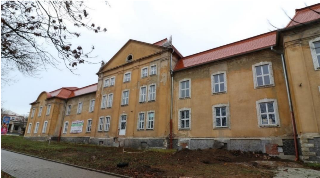
Obrázek 10 - Kasárna St. Lucia v současnosti Zdroj: Fotodokumentace vlastníka objektu
