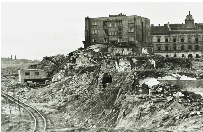
Obrázek 5 - Demolice starého Mostu Zdroj: https://mostecky.denik.cz/
