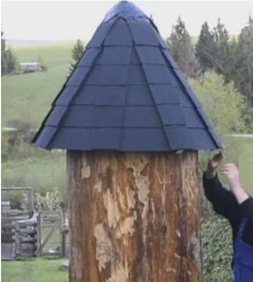
29. Střechu osadíme na klát.
