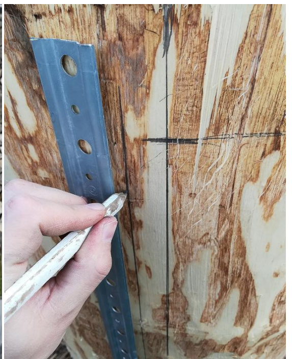
08. Podle náměrů si narýsuje dvířka, rozměr 84 x 46 cm (včetně nadmíry)
