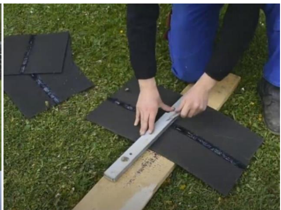
26. Nařežeme si šindele z asfaltové lepenky.
