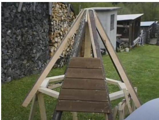
25. Nosnou konstrukci pokryjeme palubkami.
