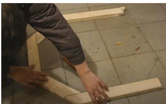
21. Připravíme si rám střechy.
