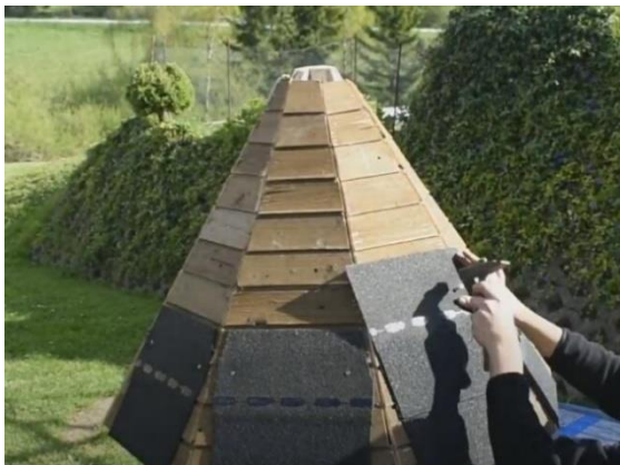
27. Šindele upevníme pomocí hřebíčků.
