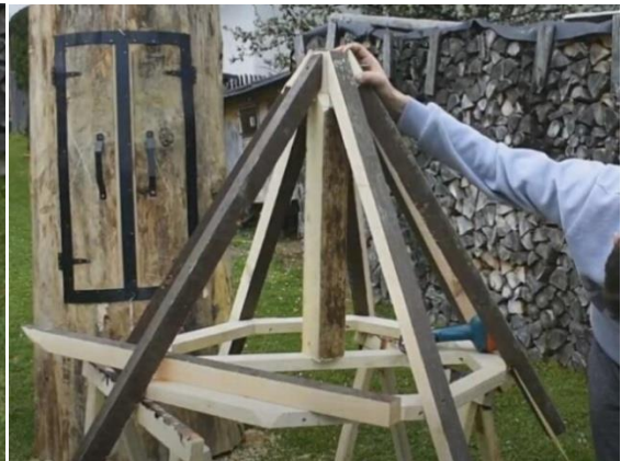
24. Osadíme zbylou nosnou konstrukci.
