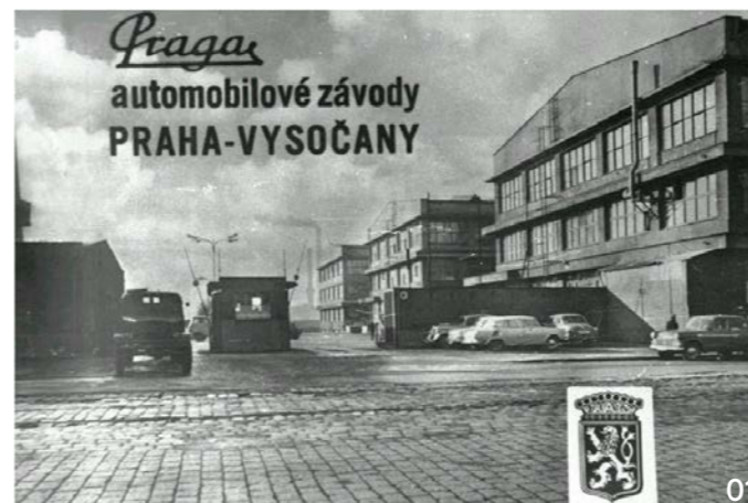
Pohlednice areálu Pragy (vpravo Hala E)
