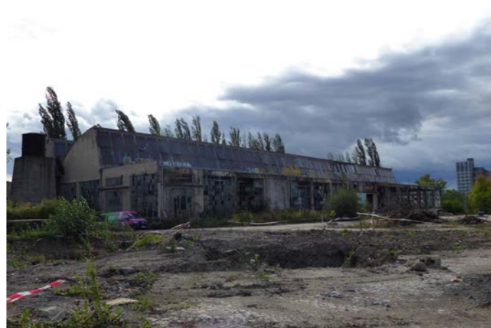
Hala č. 19, pohled ze severovýchodu
