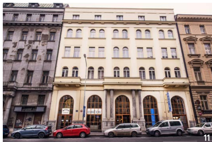
Kolej Jednota (UK) – 70./80. léta 19. st.
