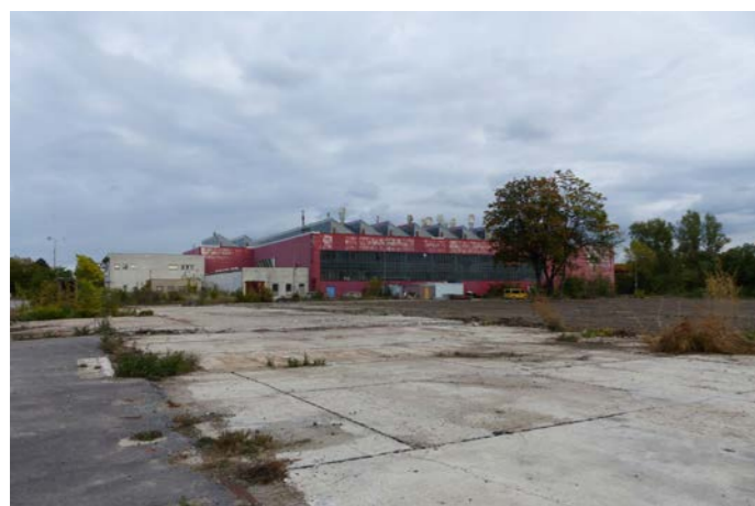
Hala č. 11, pohled od Haly č. 19
