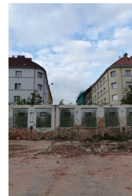
Návaznost na ulici Pod Strojírny
