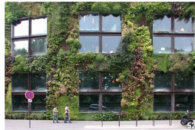
Musée du Quai Branly - Paříž - projekt: 2000-2003 - realizace: 2003-2006
