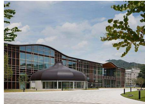
Pohled na budovu zvenku
