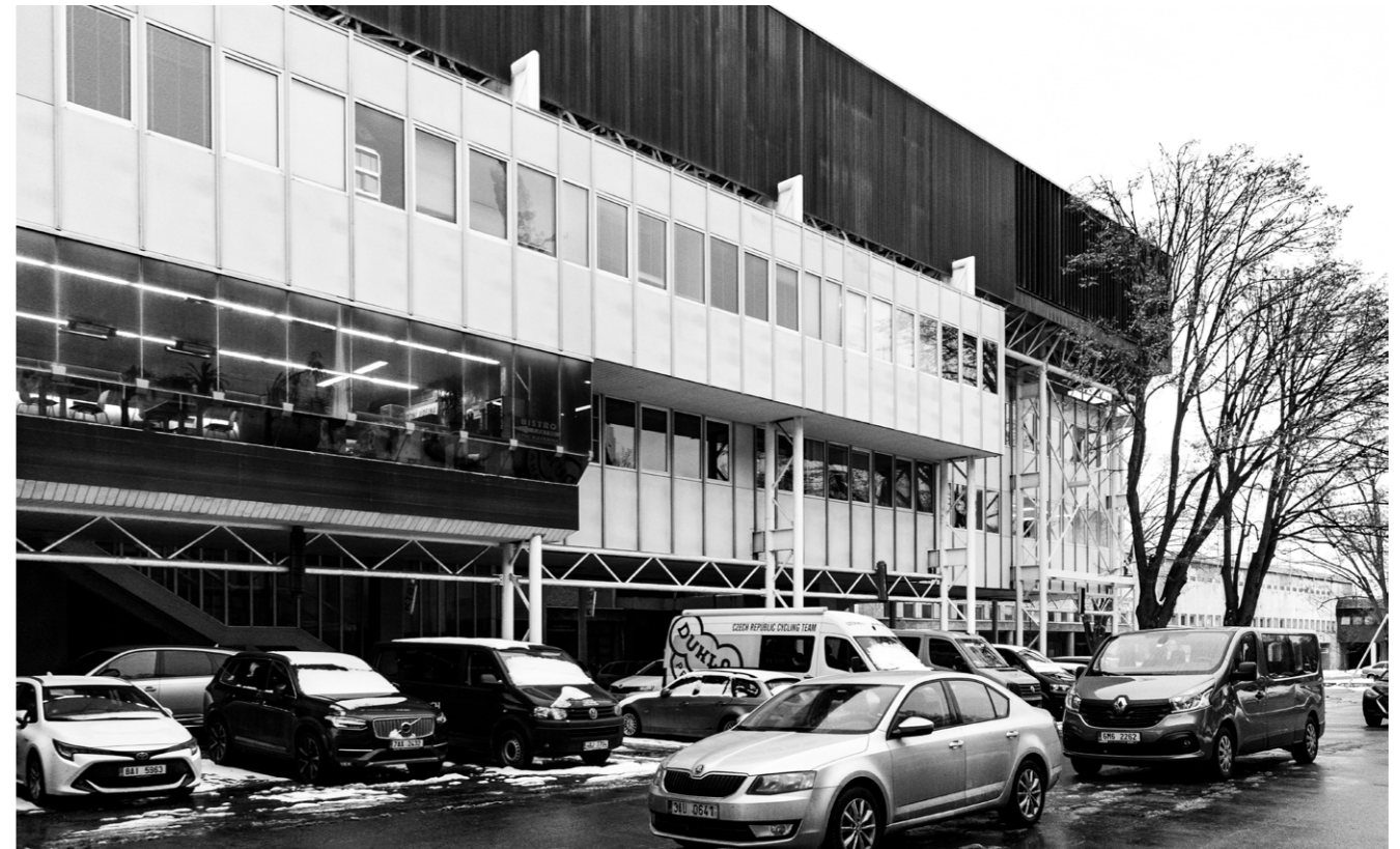
Východní část areálu, přístavba z let 1962-72
