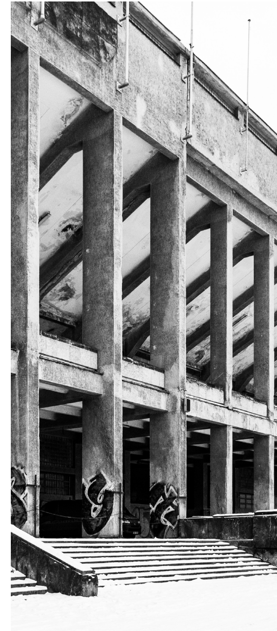
Severní část areálu, přiznaná betonová konstrukce
