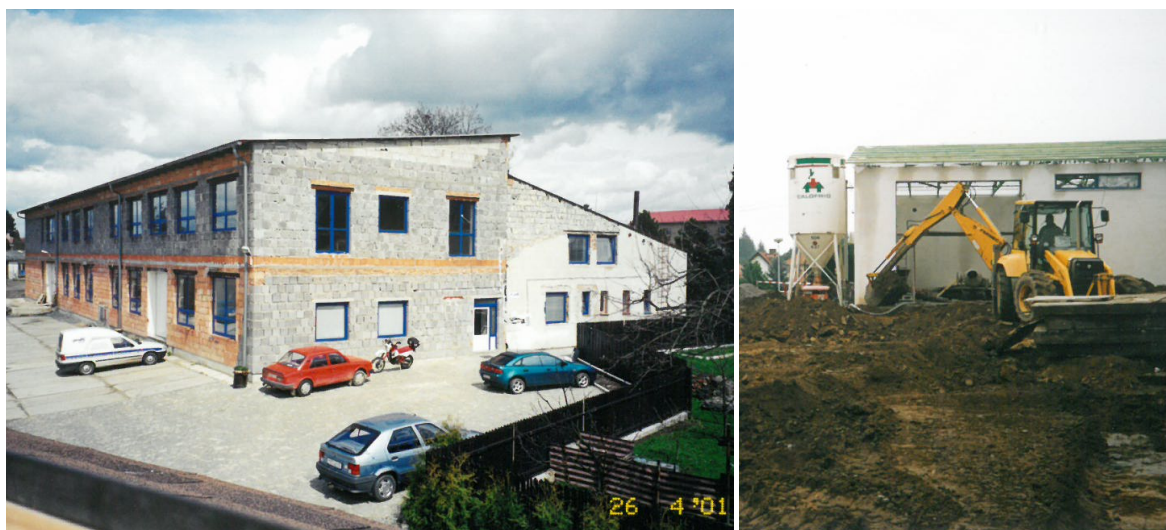
Obrázek 4 Přístavba nové výrobní haly k původním dílnám v roce 2001 a terénní úpravy v roce 2002
