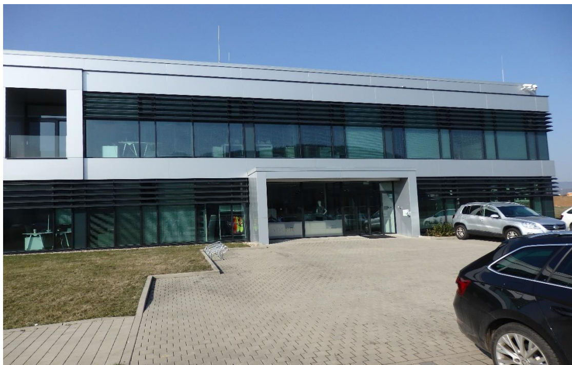
Obrázek 5.1 Východní strana objektu – hlavní vchod
