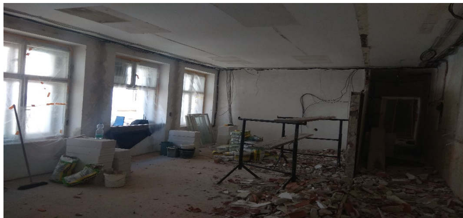
Obrázek 18 Stavební práce průběh (Foto J Prýmek)
