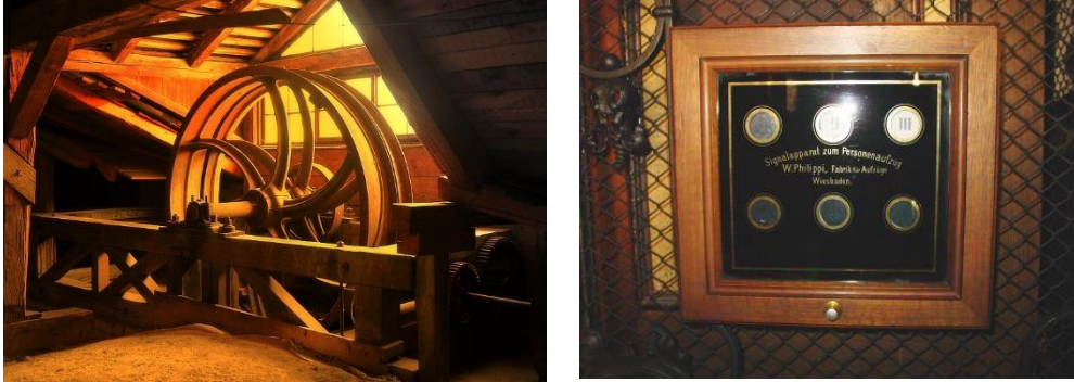
Obr. 1-8 Strojovna v zákopech [12] a ovládání Konopiště [12]
