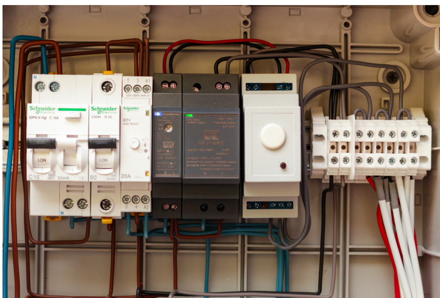
Obrázok 7.6: Riadiaca jednotka svetelného zdroja pre fototerapiu v reálnych podmienkach
