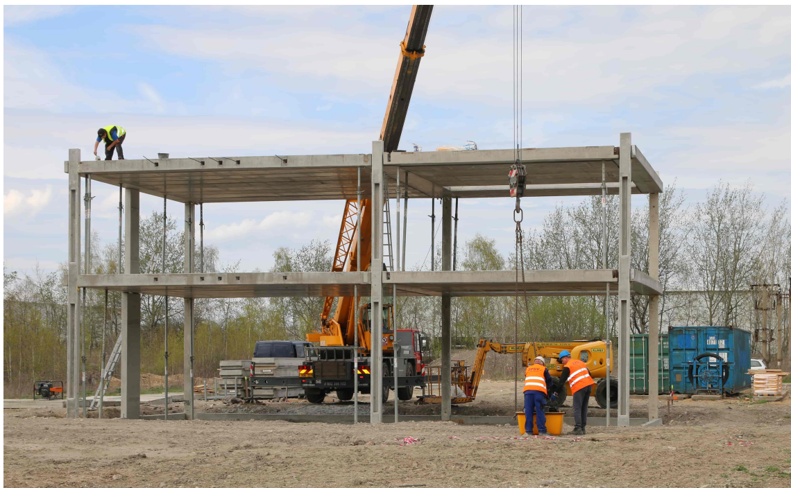
Obrázek 4.1: Výstavba nosné konstrukce
