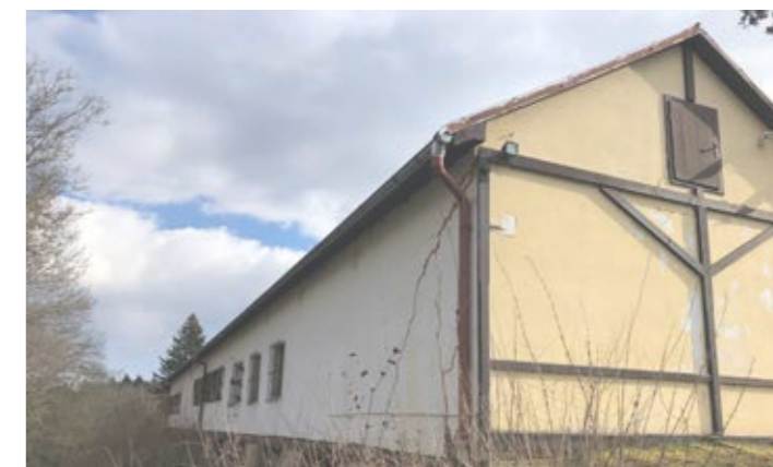
Výsek jižní fasády hospodářské budovy
