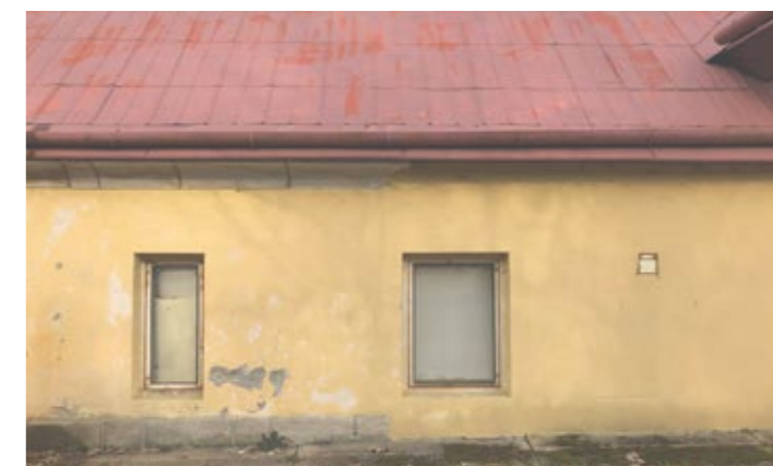
Výsek jižní fasády hospodářské budovy
