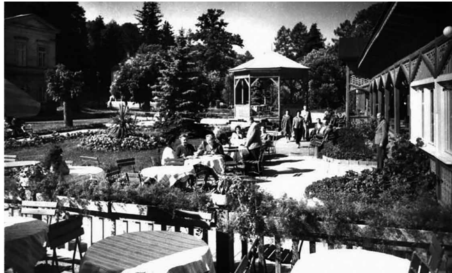
Pohled z venkovní terasy na altán, vpravo kolonáda ještě před její rekonstrukcí, kolem r. 1970 [7]
