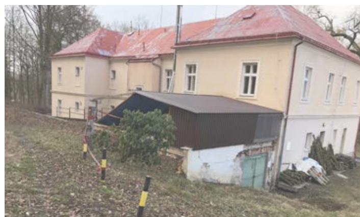
Přístavba kotelny k budově Pramen
