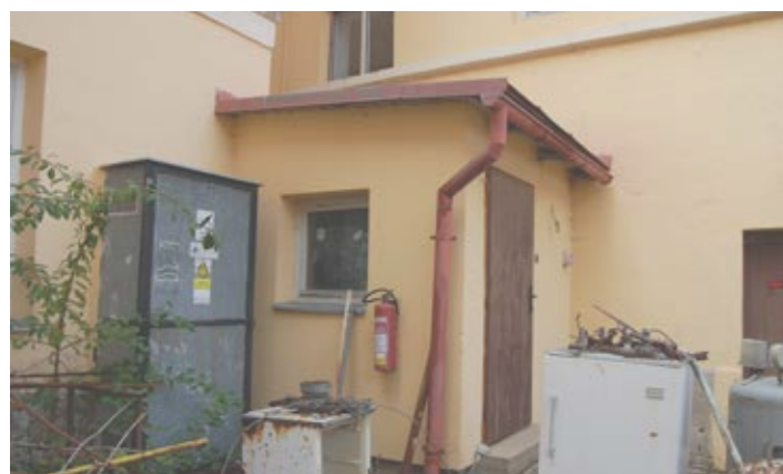
Propojovací krček mezi restaurací a budovou kuchyně
