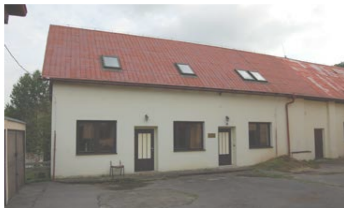
Přístavek pensionu, pohled ze dvora
