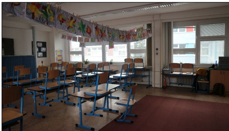
Obr. 21 - ZŠ Rakovského v Praze, učebna III.A, pohled na okenní výplně
