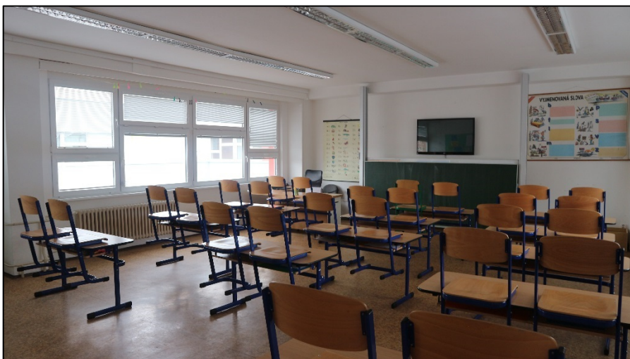
Obr. 24 – ZŠ Rakovského v Praze, učebna III.C, pohled na okenní výplně
