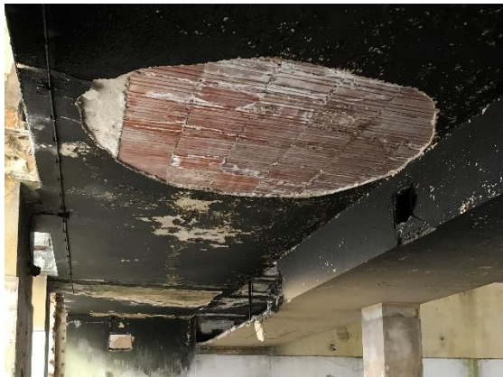
Obr. 3.16 Pohled na strop s viditelným betonovým žebrem
