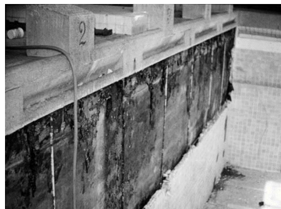
Obr. 2.3 Pohled na dutinu za čelní stěnou bazénu odhalenou při rekonstrukci (1980) [4]
