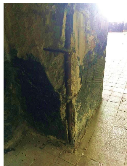
Obr. 3.46 Lokální poruchy krycí vrstvy
