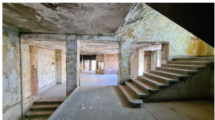
Obr. 3.18 Hlavní schodiště se vstupní halou
