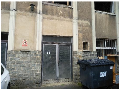
Obr. 3.33 Vedlejší vchodové dveře
