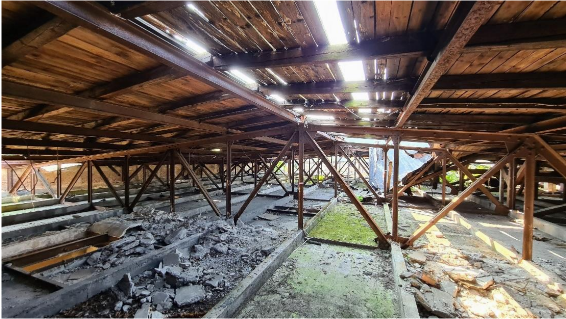
Obr. 3.22 Pohled na konstrukci vazníku se zavěšenou deskou podhledu
