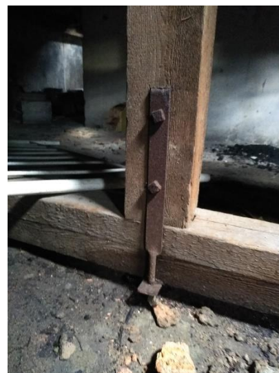
Obr. 3.27 Detail spoje věšáku a vazného trámu
