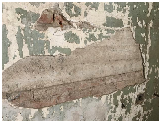
Obr. 3.12 Železobetonové žebro s cihelnou vyzdívkou
