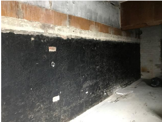
Obr. 3.35 Stěna opatřená asfaltovým nátěrem
