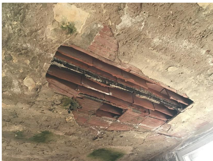
Obr. 3.50 Stav stropních konstrukcí (nadzemní podlaží)
