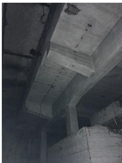
Obr. 3.39 Železobetonová konstrukce bazénu
