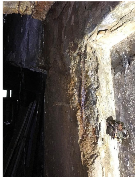
Obr. 3.75 Piliř pod výtokovým potrubím (za intenzivního deště)
