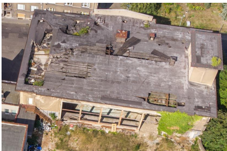
Obr. 3.55 Pohled na střechu objektu (snímek z dronu) [9]
