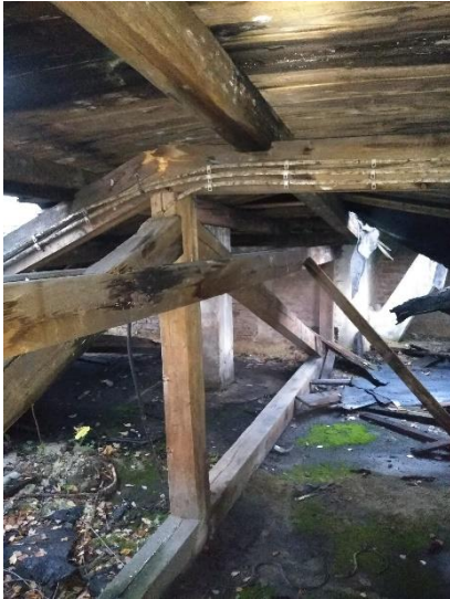
Obr. 3.63 Stav dřevěných konstrukcí
