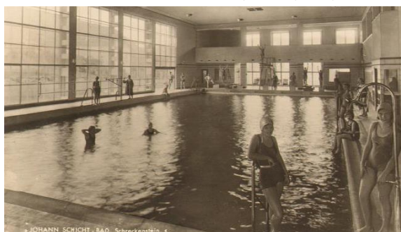
Obr. 2.2 Vnitřní plavecký bazén (1932) [2]
