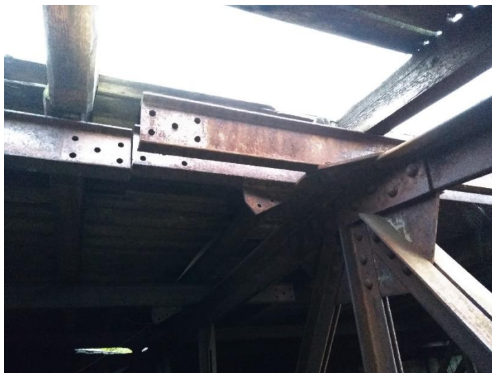
Obr. 3.59 Rozebrané spoje vaznic
