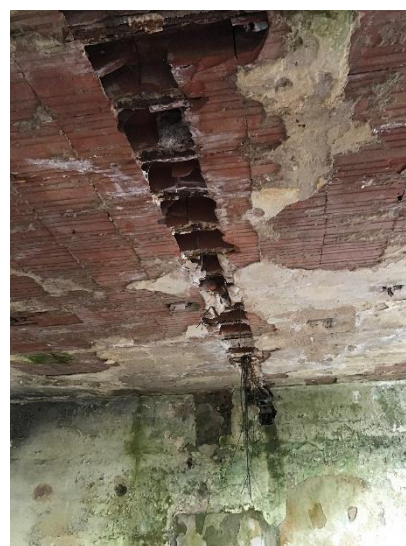
Obr. 3.49 Stav stropních konstrukcí (nadzemní podlaží)
