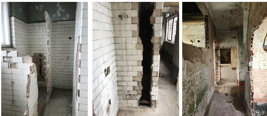
Obr. 3.28 Mezistěny z keramického obkladu se záhlvkou z VPC malty
