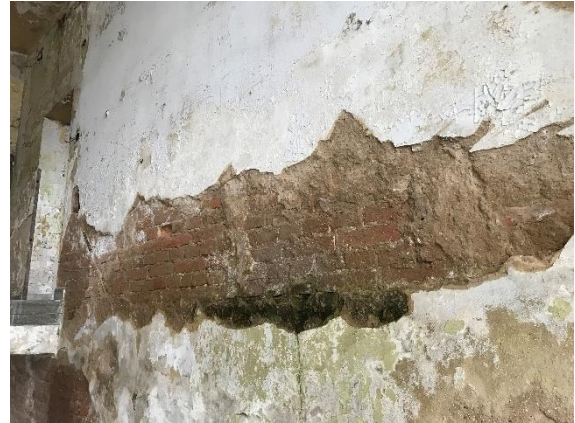
Obr. 3.5 Cihelná vnitřní nosná stěna (schodišťová)
