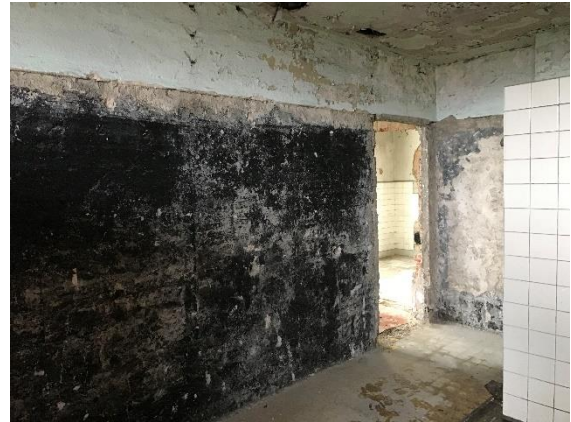
Obr. 3.36 Stěna s částečně odstraněným asfaltovým nátěrem
