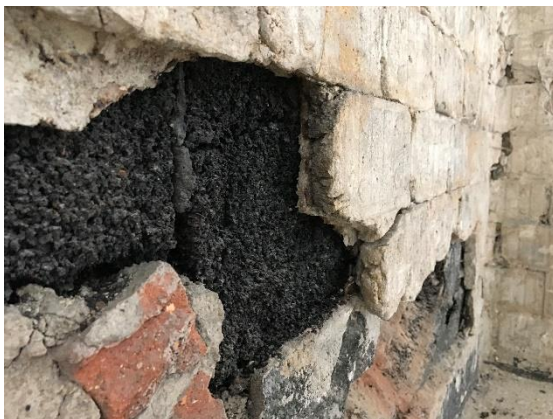
Obr. 3.7 Skladba obvodové stěny
