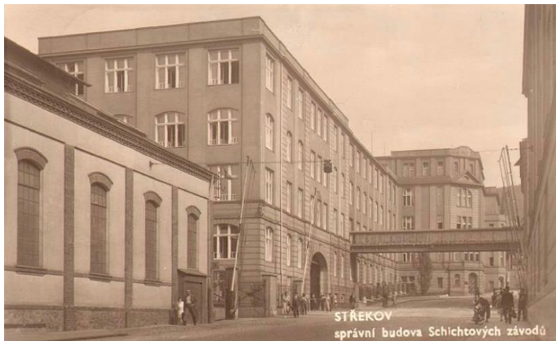
Obr. 1.3 Správní budova Schichtových závodů [2]
