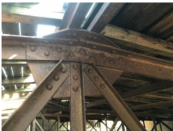
Obr. 3.24 Pohled na styčník vazníku
