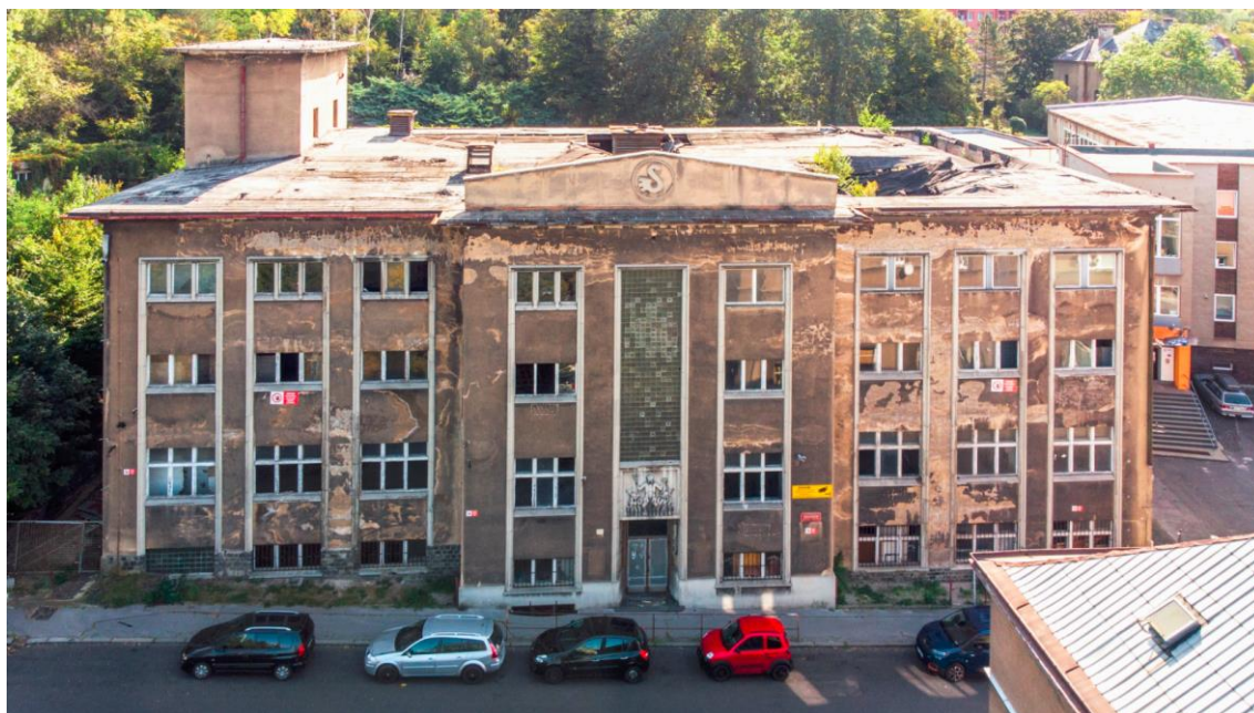
Obr. 3.2 Pohled na objekt ze severozápadní strany
