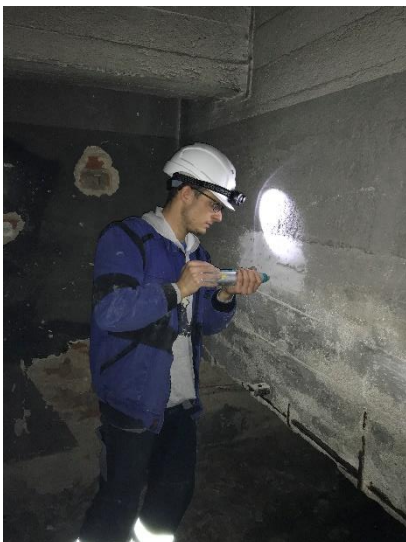
Obr. 3.90 Měření pevnosti betonu
