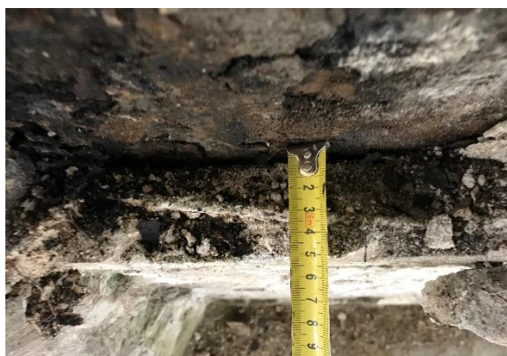
Obr. 3.85 Tloušťka cementové malty bazénové vany
