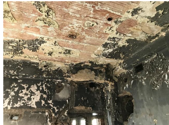
Obr. 3.17 Pohled na strop
