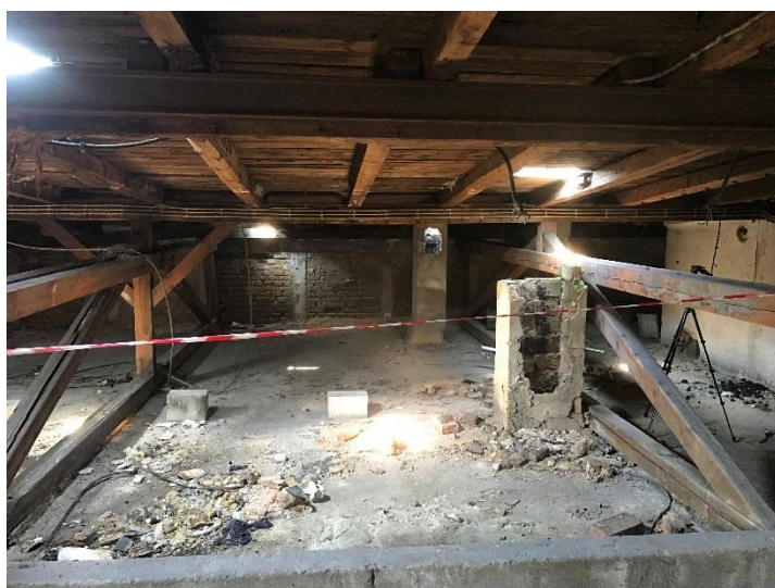
Obr. 3.26 Pohled na dřevěnou konstrukci zastřešení
