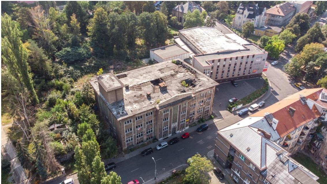
Obr. 2.5 Celkový pohled na objekt ze severu, vpravo sportovní hala
