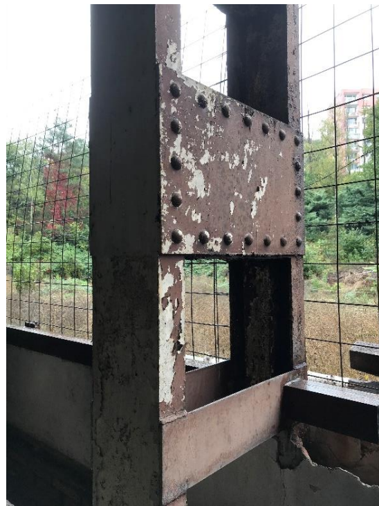
Obr. 3.9 Ocelová nosná konstrukce v otvoru bazénové haly
