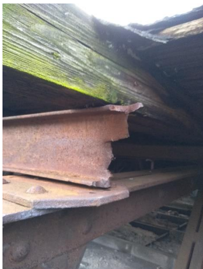
Obr. 3.58 Porušená vaznice
