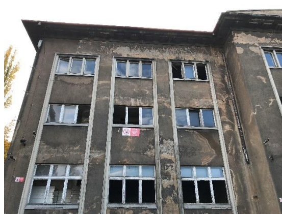
Obr. 3.66 Stav okenních výplní (SZ)
