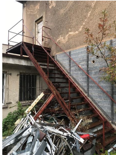
Obr. 3.21 Vnější ocelové schodiště
