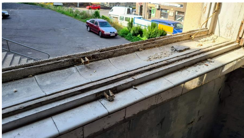
Obr. 3.31 Původní parapet kastlových oken
