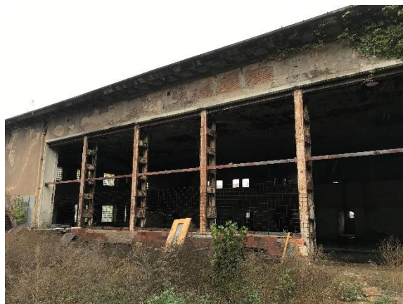
Obr. 3.10 Pohled na otvor v obvodové stěně
