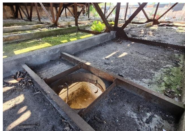
Obr. 3.25 Otvory v desce podhledu
