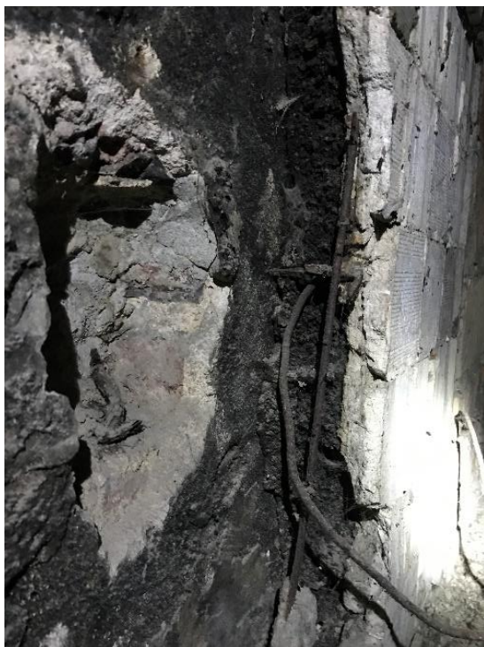
Obr. 3.8 Skladba obvodové stěny s vyztuženou omítkou
