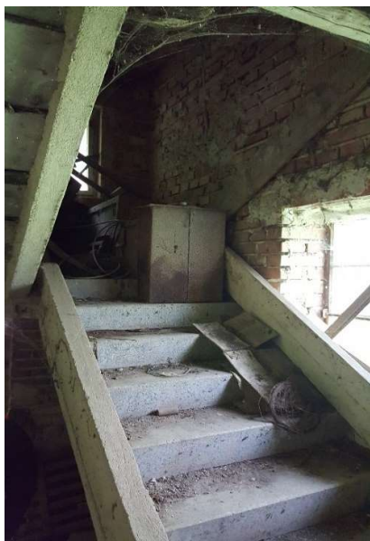
Obrázek 17: Betonové schodiště, (zdroj: autor)
