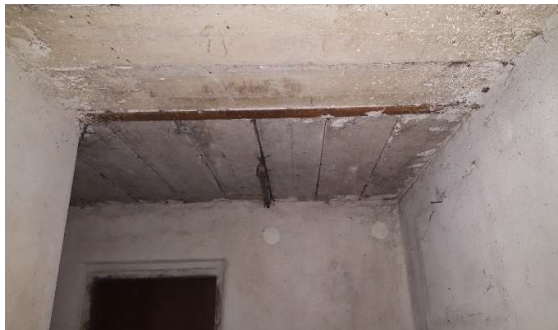
Obrázek 13: Hurdiskový strop – technická místnost, (zdroj: autor)
