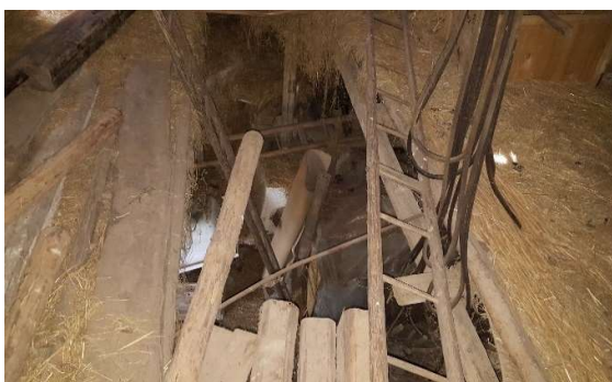
Obrázek 16: Chybějící stropní trámy nad chlévem, (zdroj: autor)
