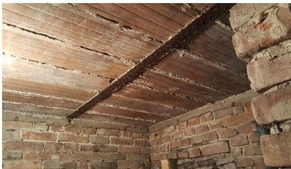
Obrázek 13: Hurdiskový strop – technická místnost, (zdroj: autor)
