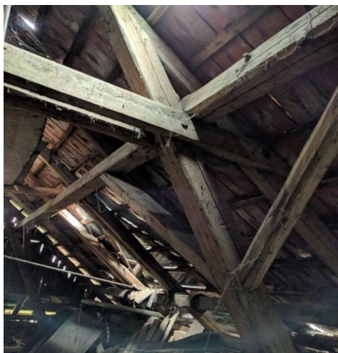
Obrázek 18: Plná vazba ležaté vaznicové soustavy, (zdroj: autor)
