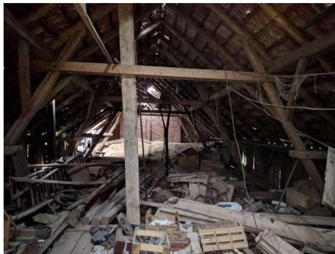
Obrázek 18: Plná vazba ležaté vaznicové soustavy, (zdroj: autor)
