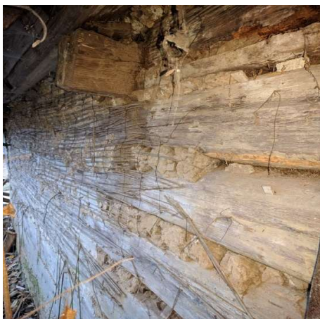
Obrázek 12: Degradované dřevěné stěny původní části stavení – západ, (zdroj: autor)
