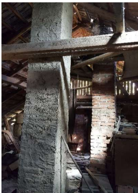
Obrázek 22: Komínová tělesa, (zdroj: autor)
