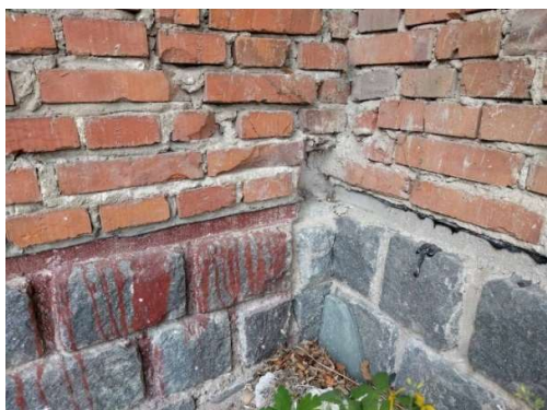
Obrázek 9: Základy pod obvodovým zdivem, (zdroj: autor)
