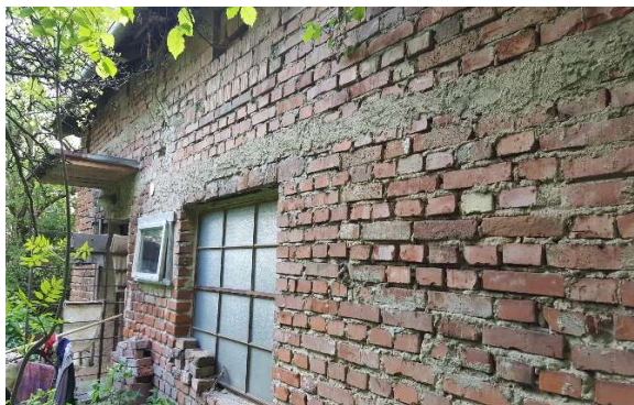
Obrázek 10: Obvodové zdivo – sever, (zdroj: autor)
