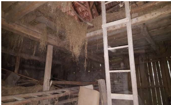
Obrázek 15: Stropní konstrukce nad chlévem, (zdroj: autor)
