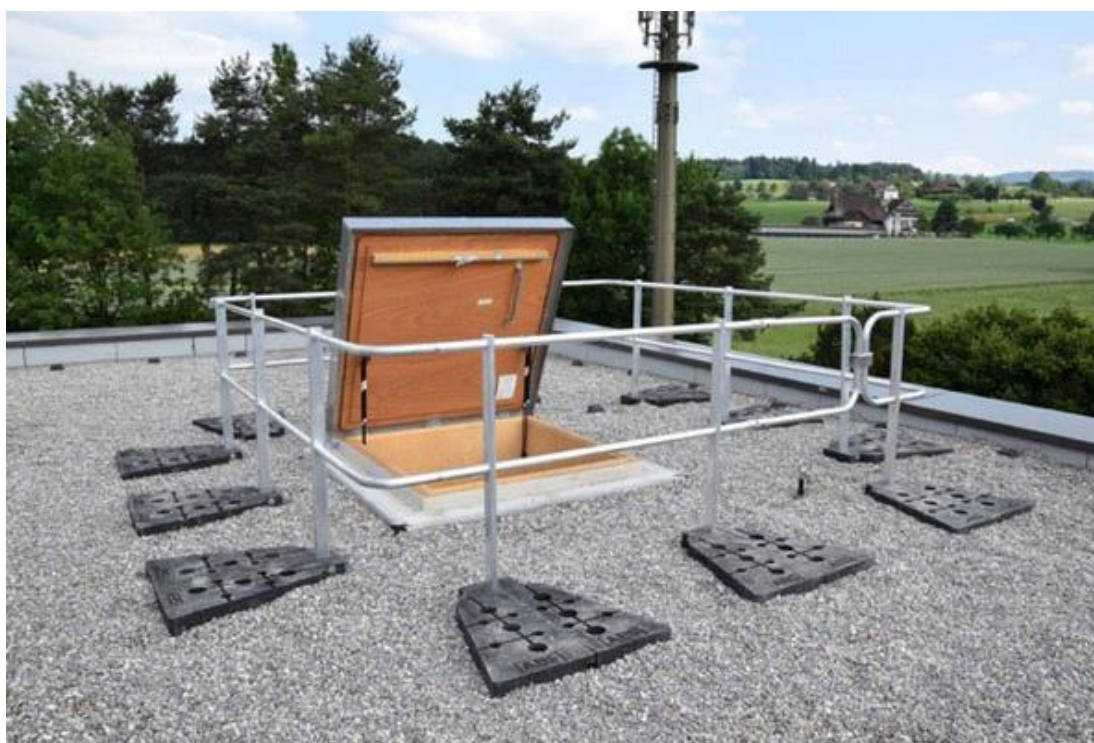
Obrázek 9: Doporučení montáže mobilního zábradlí nebo rozšíření stávajícího záchytného systému kolem otvorů Zdroj: Topsafe.cz (převzato[1])
