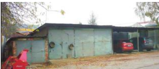
Obrázek 18 - Přední strana objektu Zdroj - Příloha 7
