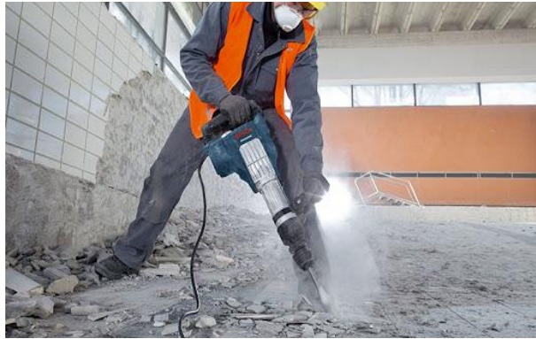
Obrázek 3 - Ruční demolice
