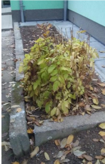
Obrázek 35 - Poškozené obrubníky [18]
