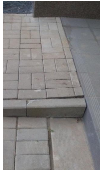
Obrázek 34 - Poškozená dlažba [18]
