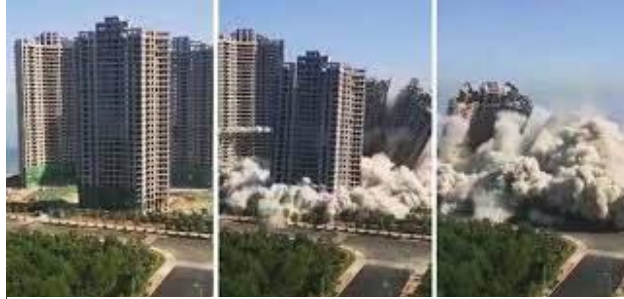
Obrázek 8 - řízená demolice trřavinou
