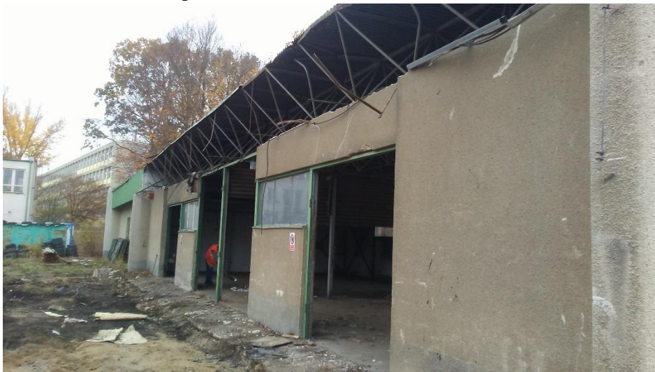
Obrázek 15 - Pohled na Objekt 18 - Garáže a sklady [21]
