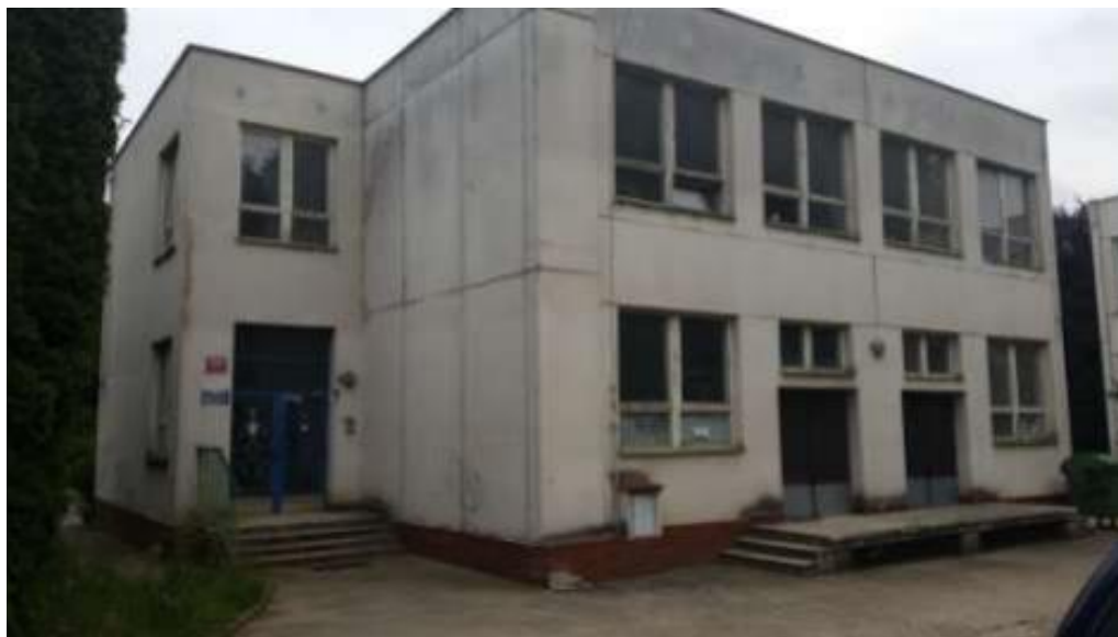
Obrázek 17 - Pohled na Objekt 17a [19]
