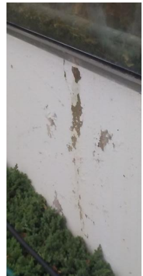
Obrázek 30 - Opadající omítka [17]
