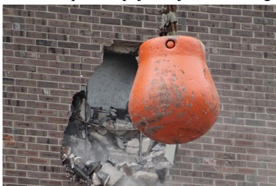
Obrázek 5 - Demoliční koule – hruškovitý tvar
