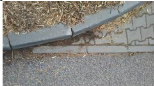
Obrázek 40 - Poškozený obrubník [23]
