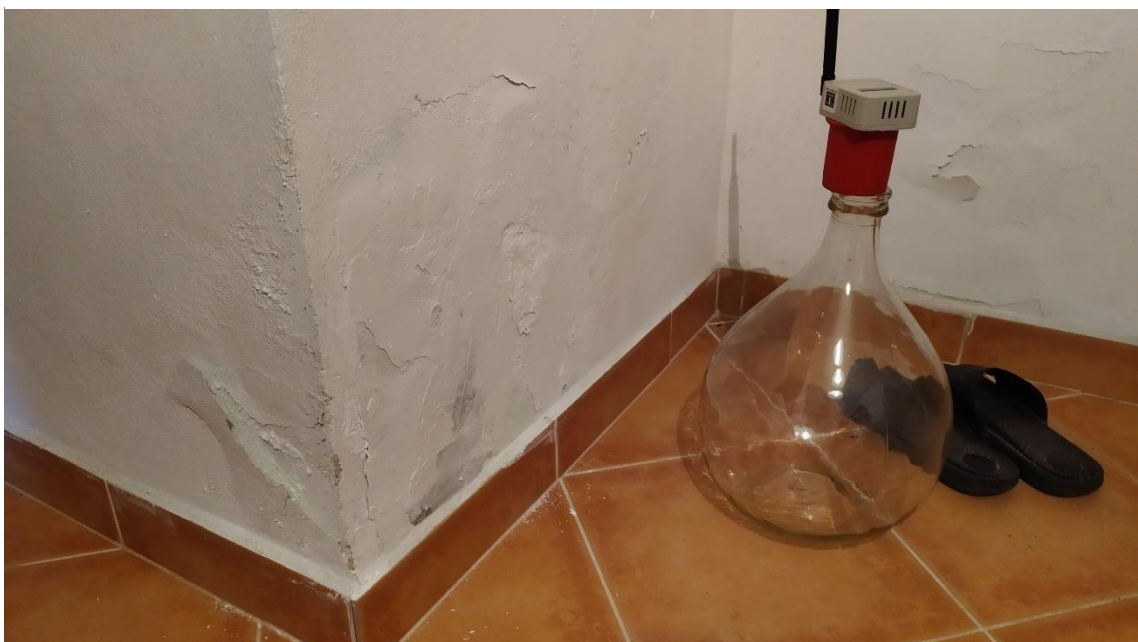
Obr.13 – Vlhká stena a opadaná omietka v m 1.04
