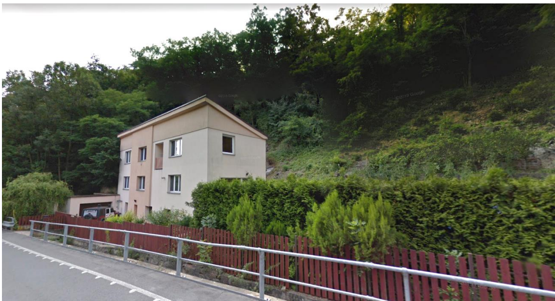
Obr. 3 - Pohľad na SV fasádu objektu, zdroj: Google Maps [10]
