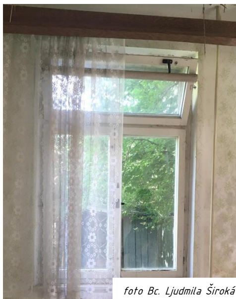
Obrázek 10 – Stávající dřevěné zdvojené okno
