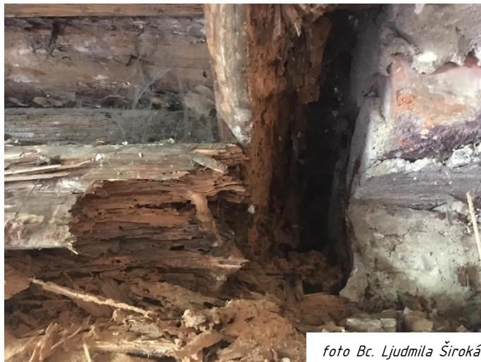
Obrázek 32 – Současný velmi špatný stav krokví a pozednic
