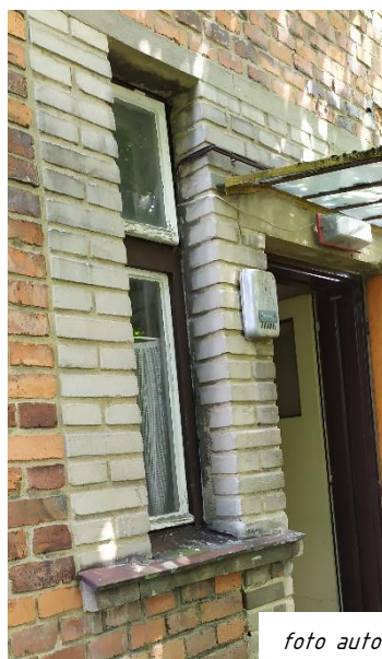
Obrázek 11 – Stávající dřevěné dvojitě okno do koupelny
