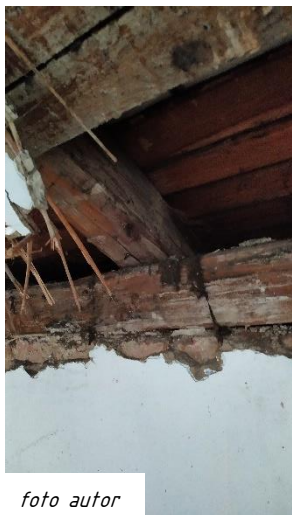
Obrázek 32 – Současný velmi špatný stav krokví a pozednic
